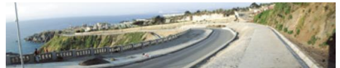
Nuevo camino costero acceso Torpederas
