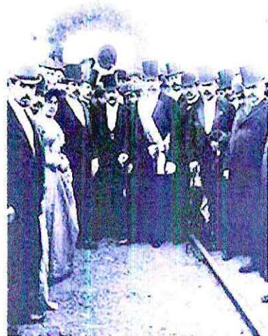
FIGURA 9, INAUGURACIÓN DEL VIADUCTO DEL MALLECO POR EL PRESIDENTE JOSÉ MANUEL BALMaceda
