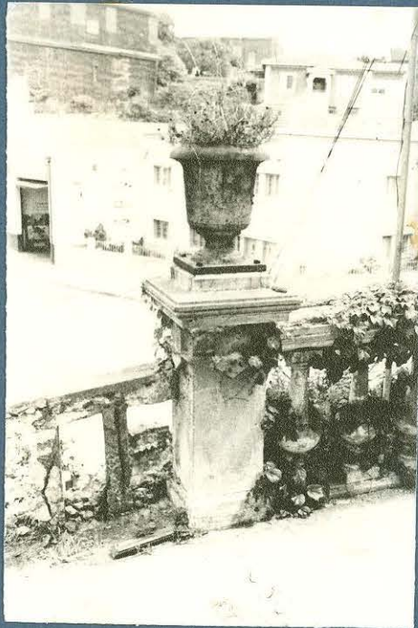
FOTO 8: Detalle de empalme de pasamano entre la horizontal y la diagonal.
