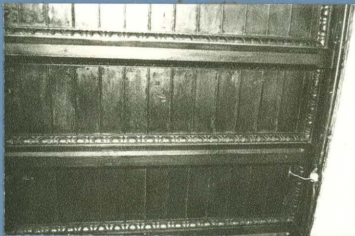
FOTO 18: Vigas de pino oregón a la vista en hall central.
