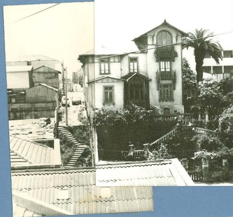
FOTO 37: La vivienda desde la quebrada en su costado norte.
