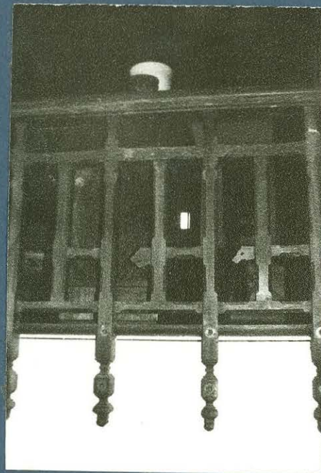
FOTO 6: Detalle baranda escalera interior.
