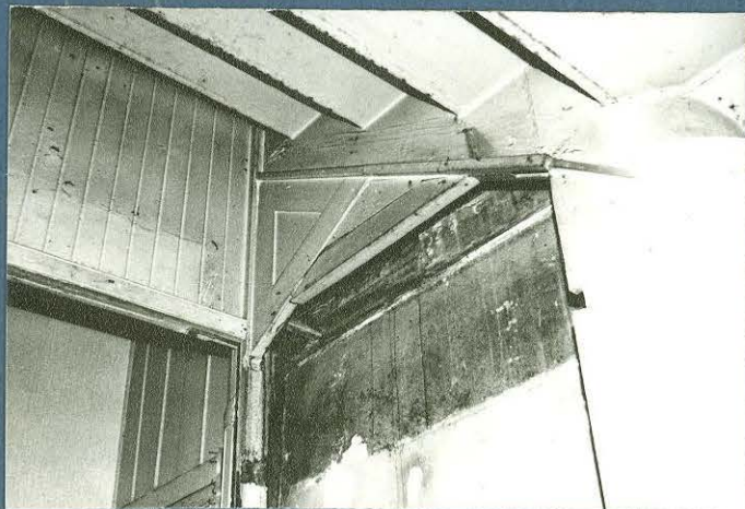
FOTO 16: Vista de la escalera desde el espacio intermedio del primer nivel.
