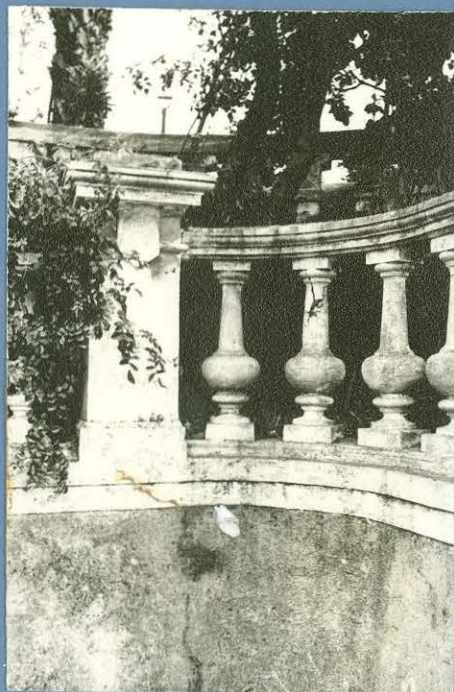
FOTO 22: Pasamano y balantrada en el acceso principal exterior.
