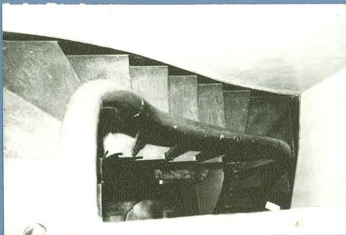
FOTO 17: Escalera helioidal - acceso al 3er. piso.
