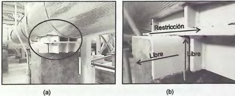
Figura 2.12 - a) Cañería con restricción longitudinal b) Restricciones y desplazamientos permitidos del apoyo
