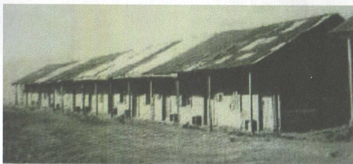
Pabellón N° 11 construido en 1906
