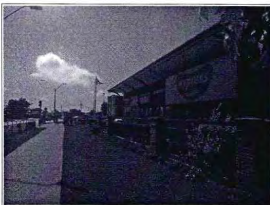
Centro de abastecimiento de alimentos, Calles Av. Ed. Frei con del Avellano.
