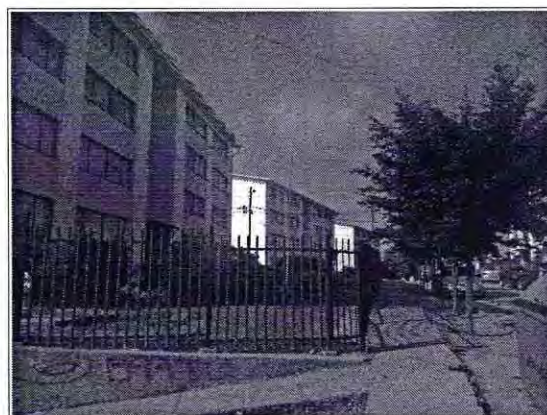
Edificación de mediana altura U.V. 115
