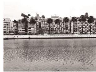
Tramo 3 Borde Calle / Río
