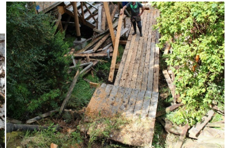
Reparación de pasarela, se hace por tramo se desmonta la pasarela antigua y se cambian por tablones de Ciprés.
