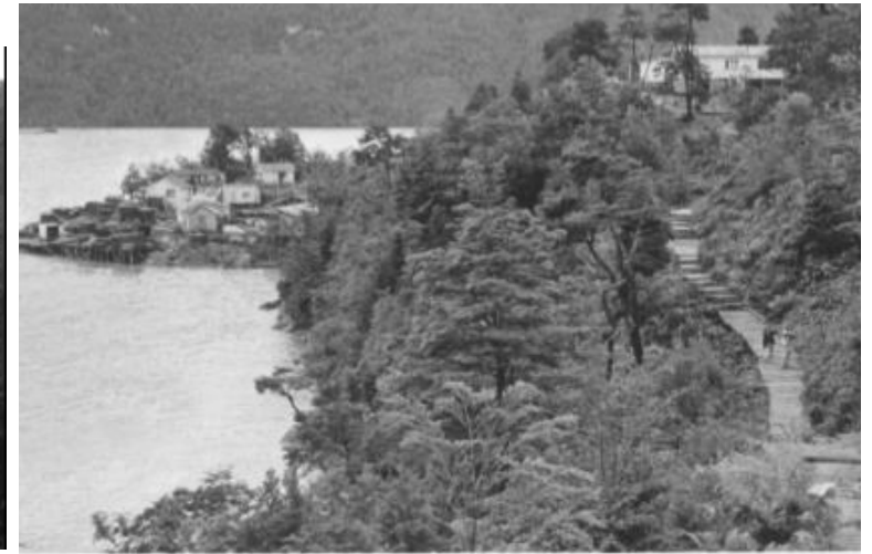
Figura 32. Pasarelas Sector Centre con vista a castillos de madera en sector Capitanía de Puerto Baker.
