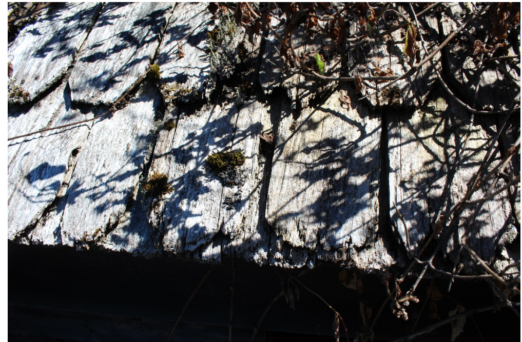
Figura 1. Cubierta teja de madera, Tortel. Fotografía Alejandra Olivares
