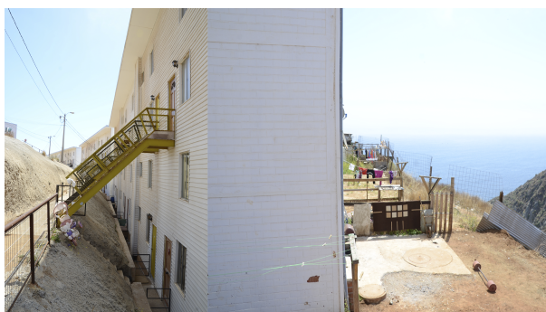
Figura 6.4: Fotografía: Acceso viviendas y patios
