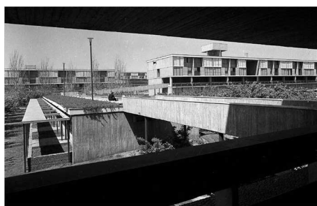
Figura 5.12: Fotografía desde interior pasillo común
