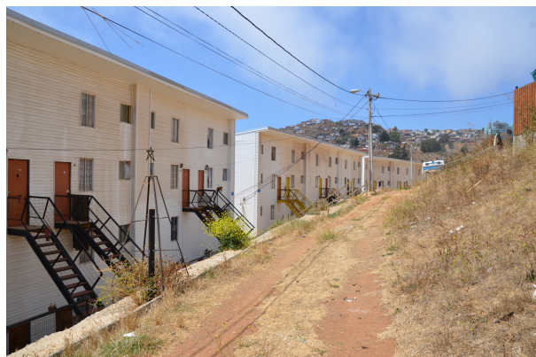
Figura 6.6: Fotografía Lote B3
