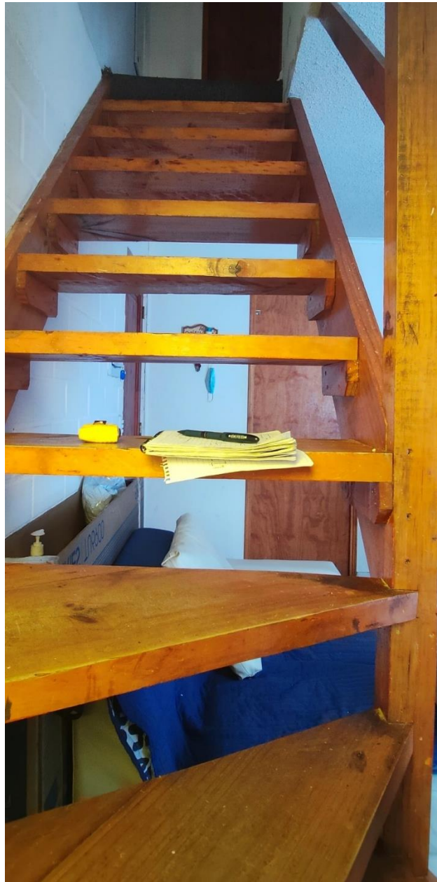
Figura 7. 2 - Fotografía-Escalera evaluada- LOS NARANJOS III: Peña Blanca.
