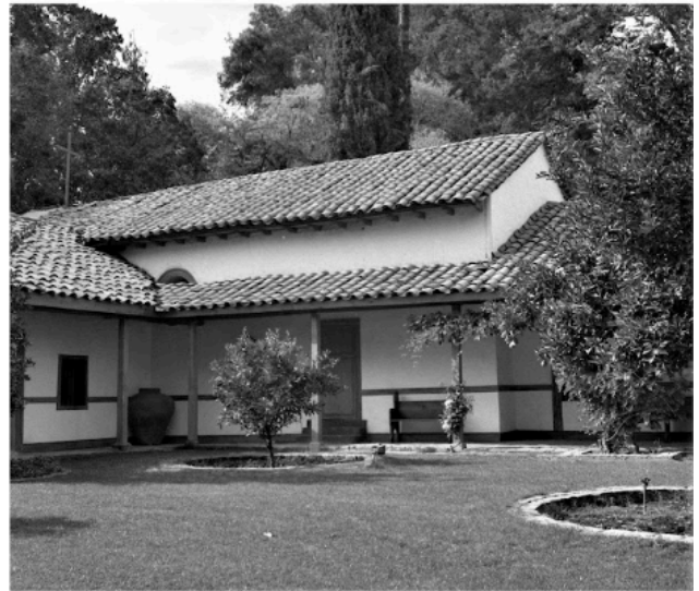
ARCHIVO FOTOGRÁFICO DIRECCIÓN DE ARQUITECTURA
