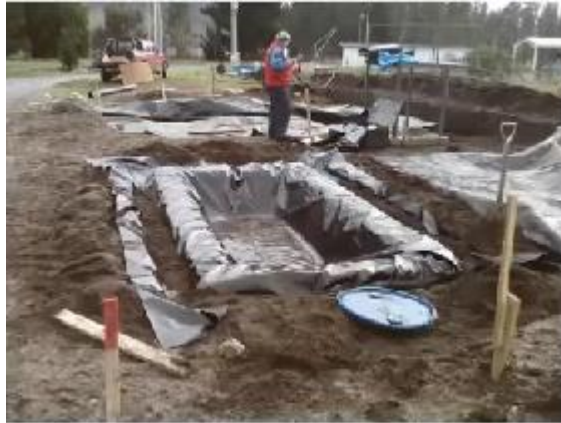
Figura 5.8: Lámina de HDPE instalada usando zanja perimetral
