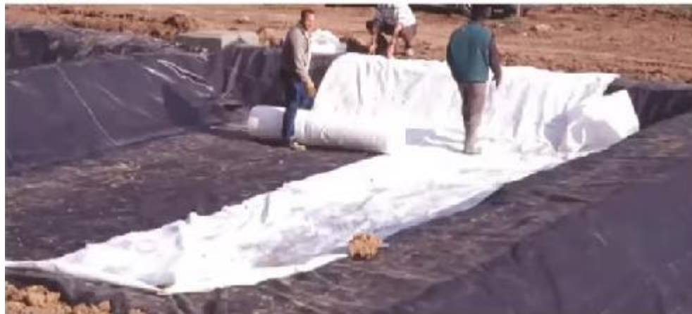
Figura 5.9: Lámina dispuesta siendo cubierta con geotextil.
