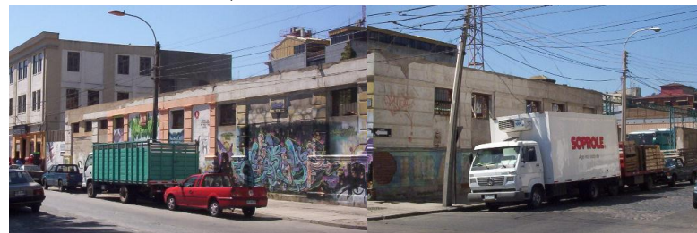
9. Demolición de últimos pisos en edificios a causa de los continuos terremotos.
