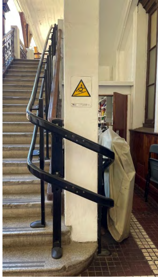
Figura N°3.82: Plataforma elevadora. Fuente: Elaboración propia.
