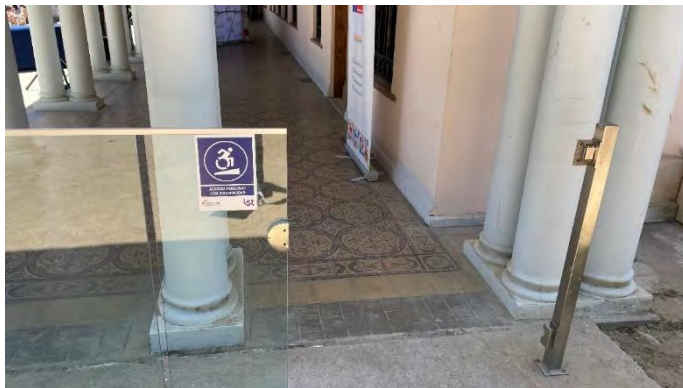
Figura N°3.23: Acceso secundario. Fuente: Elaboración propia.
