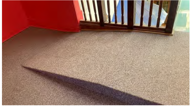
Figura N°3.109: Rampa interior. Fuente: Elaboración propia.
