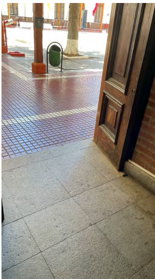
Figura N°3.64: Rampa acceso a patio. Fuente: Elaboración propia.
