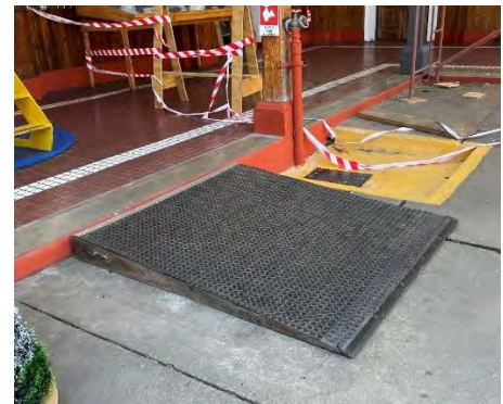
Figura N°3.80: Rampa patio interior. Fuente: Elaboración propia.
