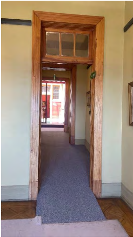
Figura N°3.108: Rampa interior. Fuente: Elaboración propia.
