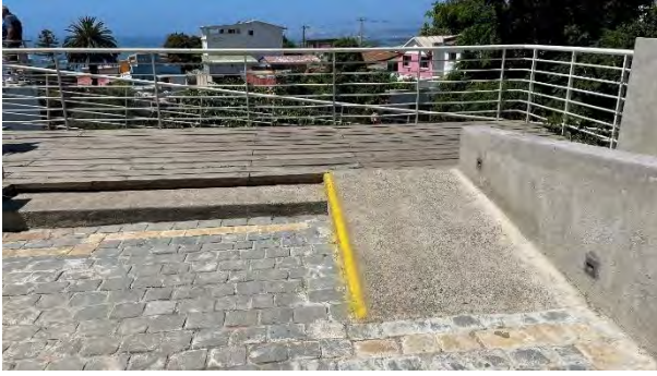
Figura N°3.171: Rampa terraza. Fuente: Elaboración propia.
