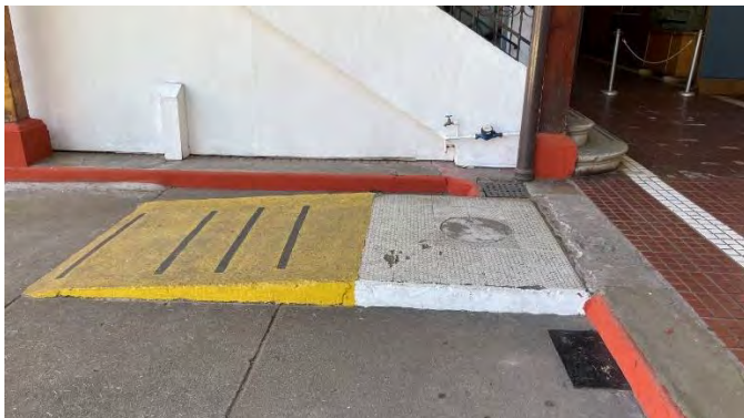
Figura N°3.79: Rampa patio interior. Fuente: Elaboración propia.
