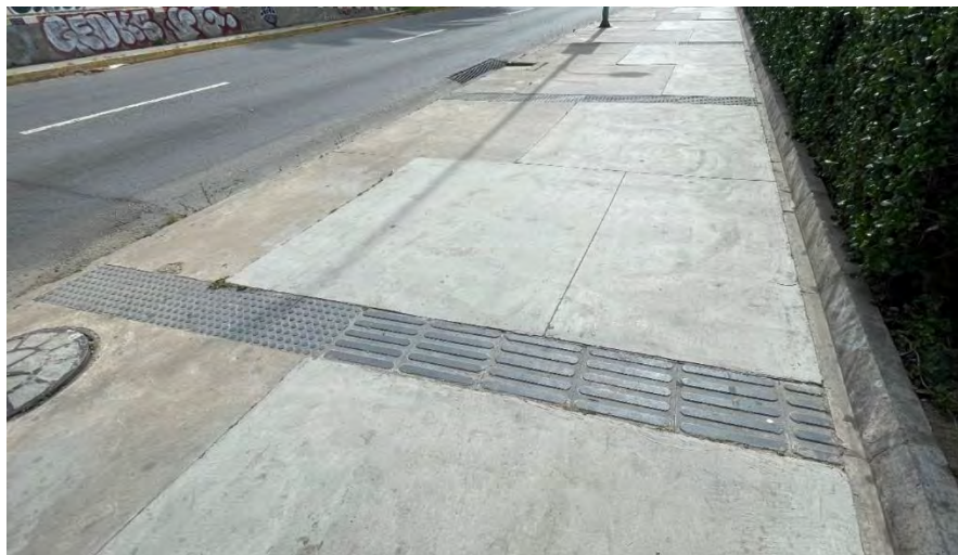
Figura N°2.13: Baldosas de avance seguro con baldosas de alerta. Fuente: Elaboración propia.
