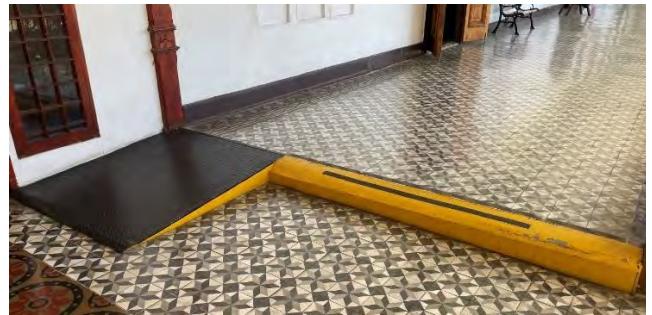
Figura N°3.84: Rampa con escalón. Fuente: Elaboración propia.
