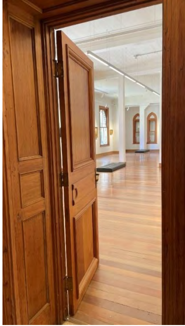
Figura N°3.30: Puerta estrecha. Fuente: Elaboración propia.
