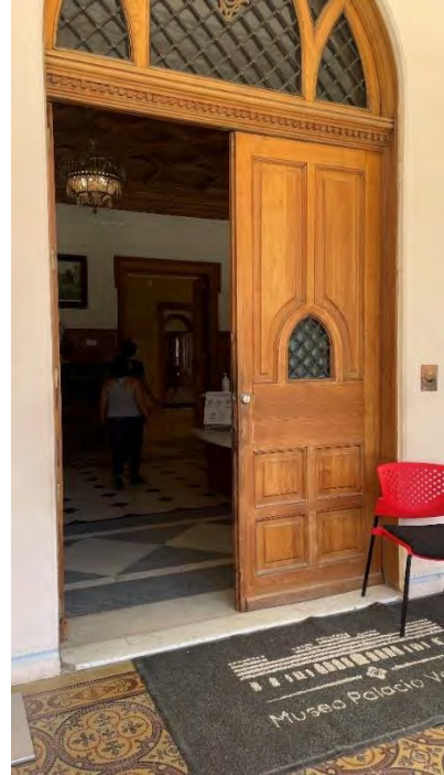
Figura N°3.22: Acceso puerta principal. Fuente: Elaboración propia.
