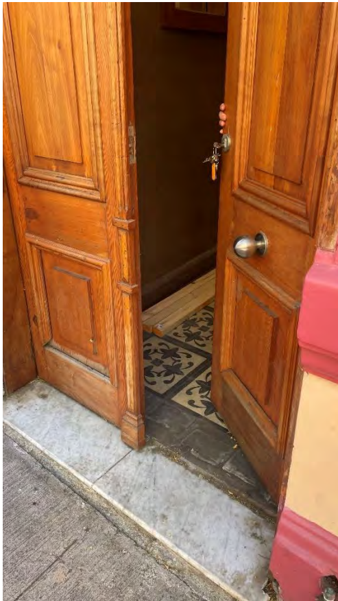
Figura N°3.122: Acceso secundario. Fuente: Elaboración propia.
