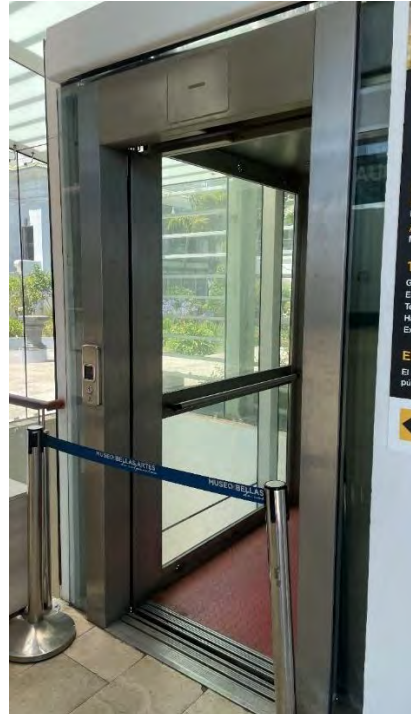
Figura N°3.103: Ascensor piso subterráneo. Fuente: Elaboración propia.
