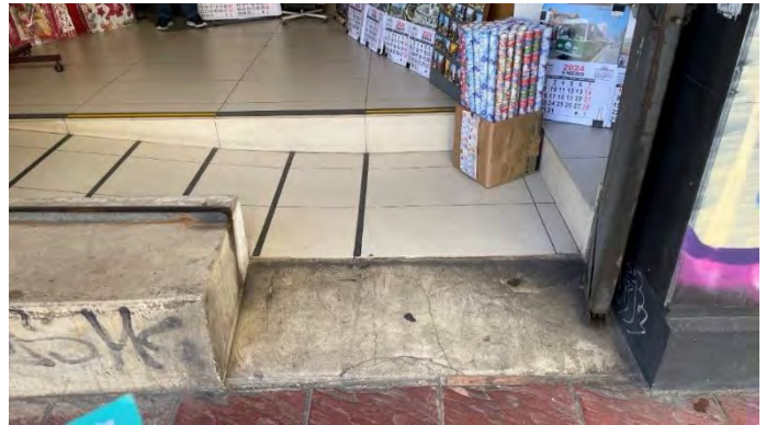
Figura N°3.90: Acceso secundario. Fuente: Elaboración propia.
