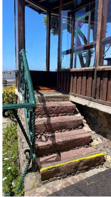
Figura N°3.164: Escalera acceso principal. Fuente: Elaboración propia.
