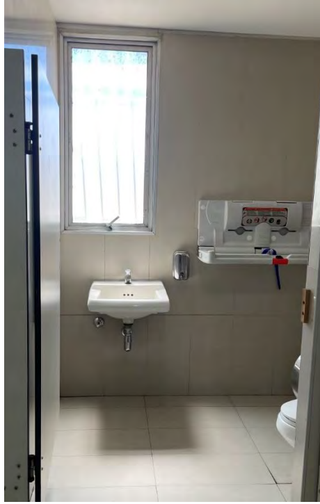
Figura N°3.85: Acceso baño adaptado. Fuente: Elaboración propia.
