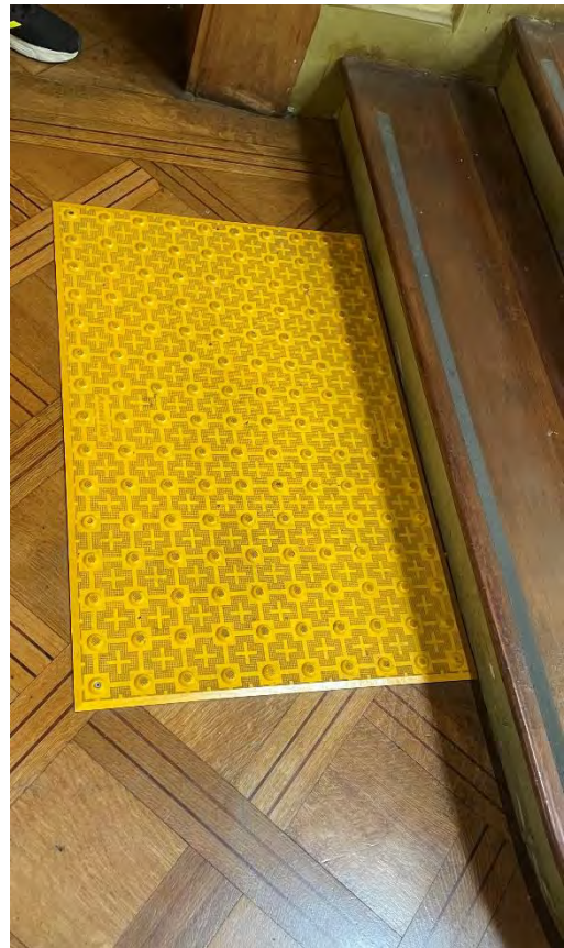
Figura N°3.107: Alerta escalera. Fuente: Elaboración propia.
