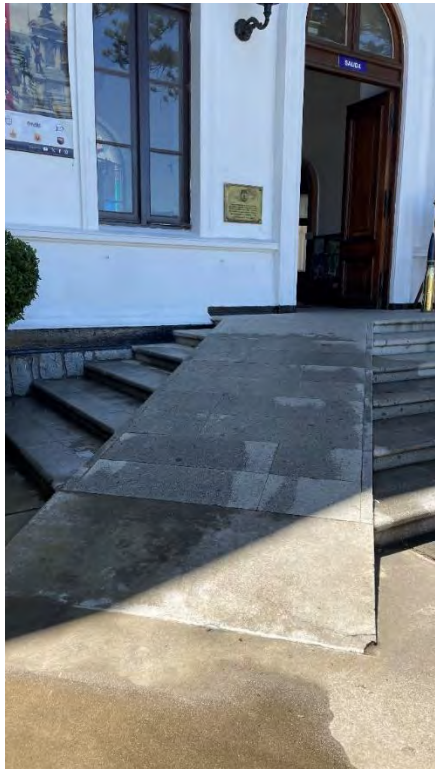
Figura N°3.59: Rampa principal Fuente: Elaboración propia.
