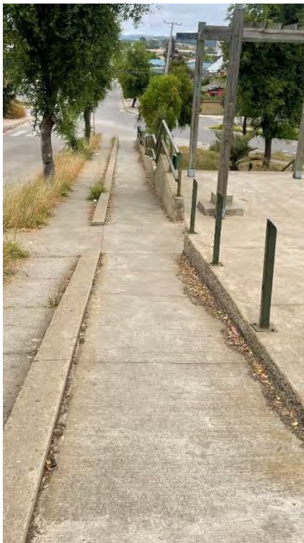
Figura N°3.150: Rampa de acceso. Fuente: Elaboración propia.
