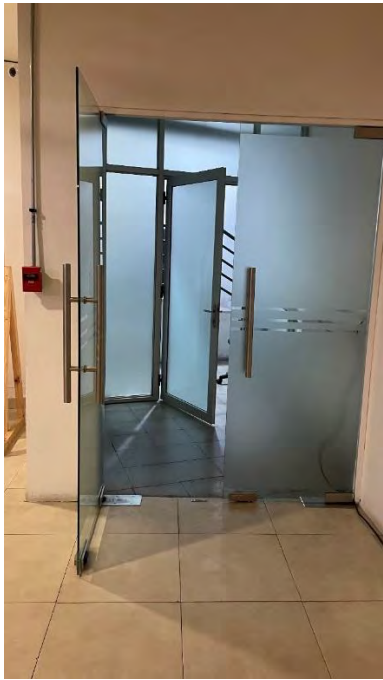
Figura N°3.95: Acceso piso subterráneo. Fuente: Elaboración propia.
