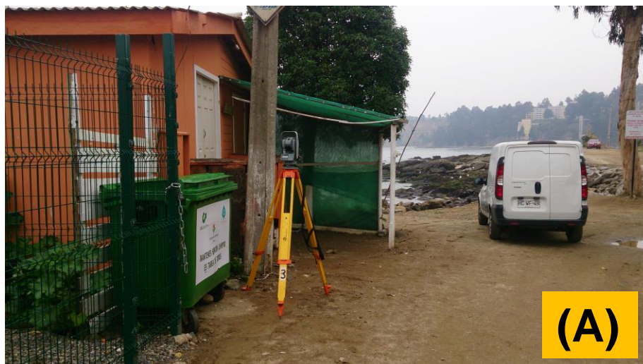
Figura 1.3: Foto en terreno 1. Fuente: DOP (24-05-2017).
