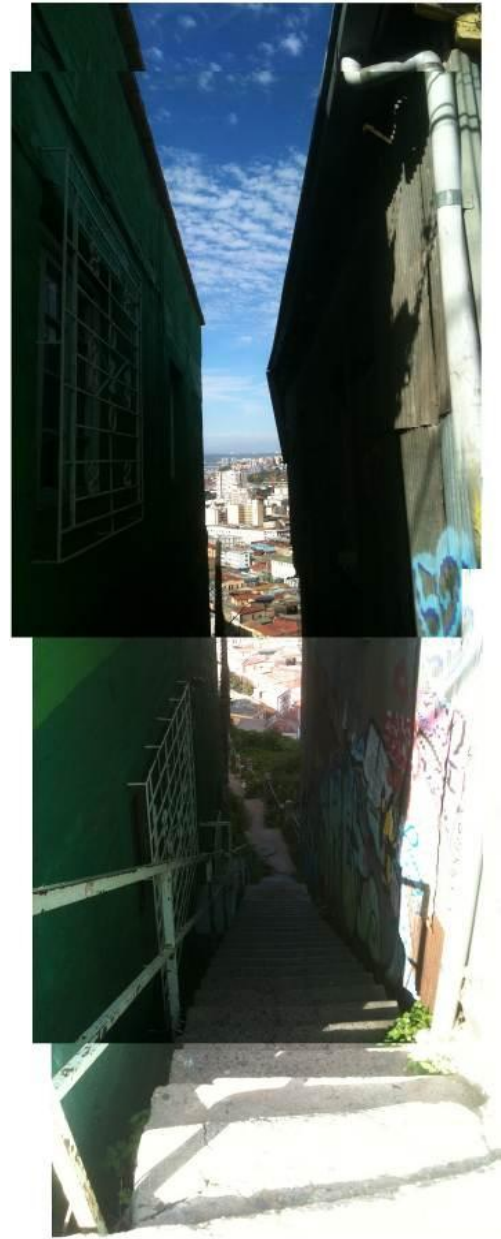
Fisuras desde la cima del ascensor Florida
