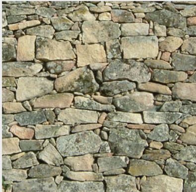
muro de contención, revestido con mampostería de piedra en bruto.
