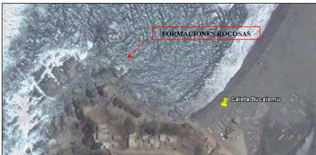
Figura 1-2 Ubicación de Macizo Rocosos en Caleta Bucalemu (Fuente Elaboración Propia)
