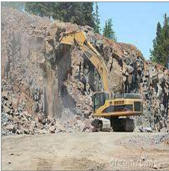
Figura 2.11 a), Excavación en Roca
