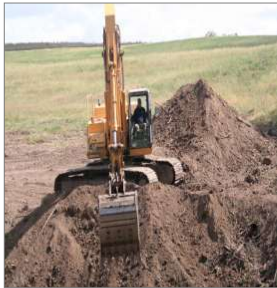
Figura 2.11 b), Excavación en suelo común
