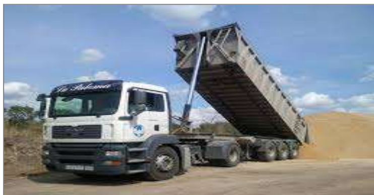
Figura 2.14, Camión en descarga
