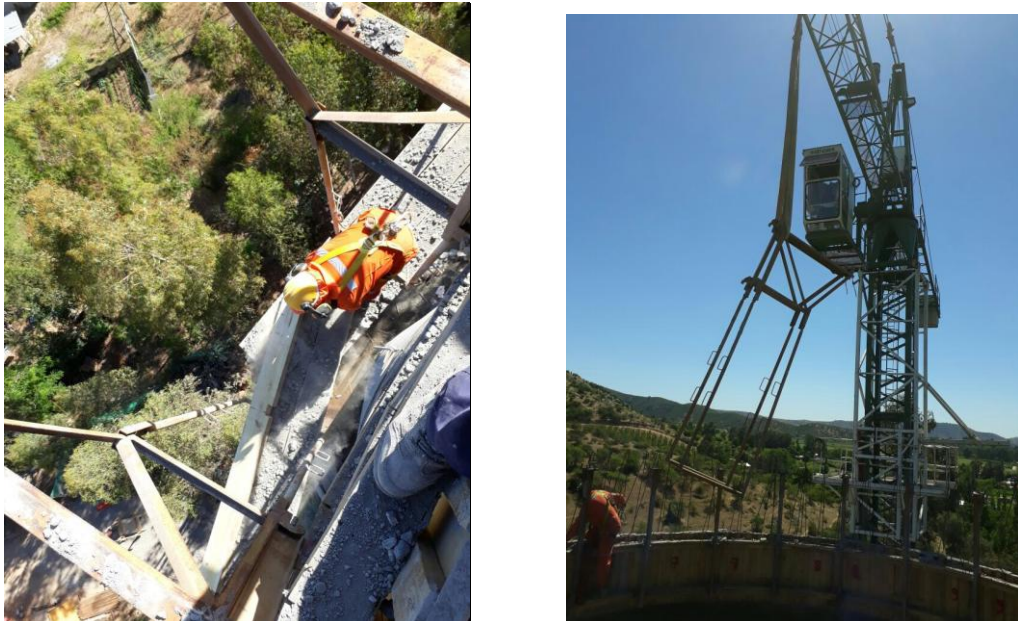
Imagen 5.30: Desmontaje de conjunto plataforma inferior y superior del sistema de moldaje deslizante
