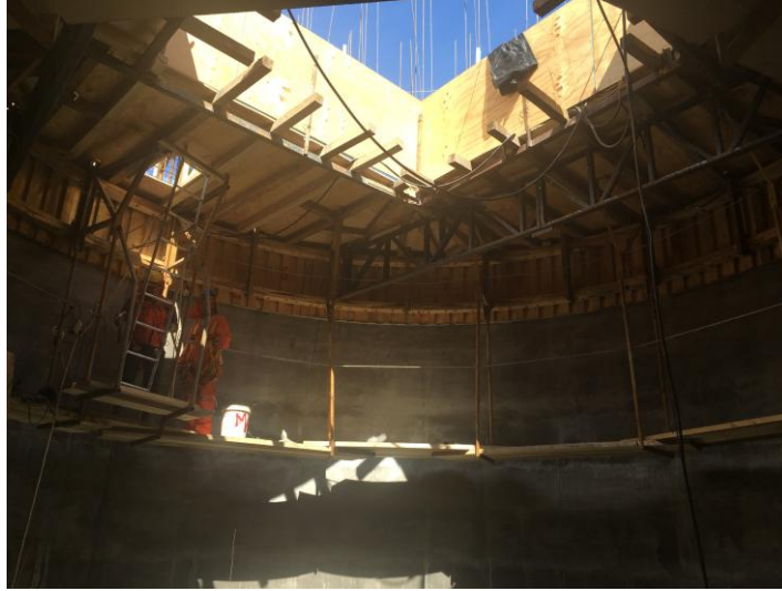
Imagen 5.26: Trabajos en plataforma de trabajo inferior interna
