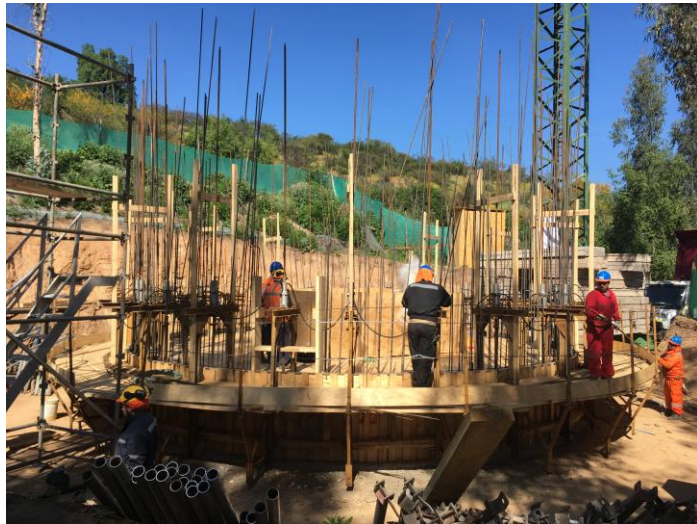
Imagen 5.23: Colocación de armaduras en plataformas de trabajo superior
