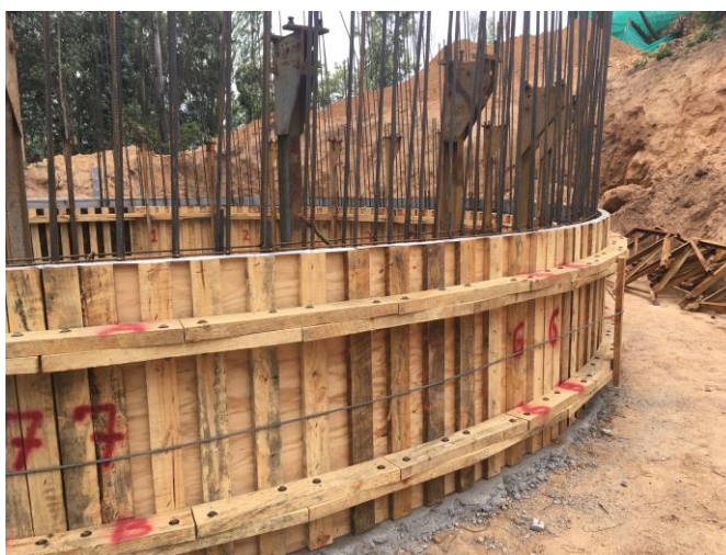
Imagen 5.6: Instalación de Caballete en cara interior de la estructura
