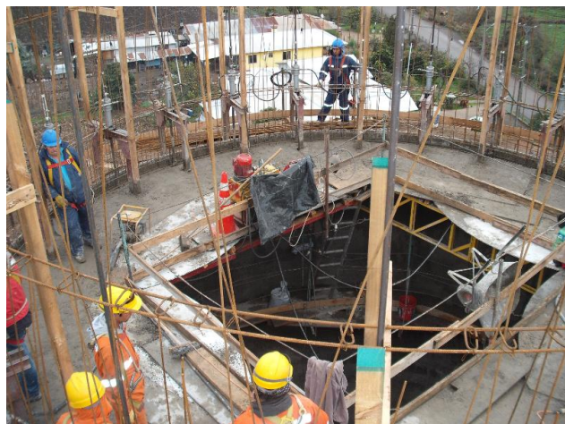
Imagen 5.14: Plataforma de trabajo interior con adición de Viga Metálica
