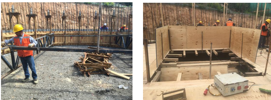
Imagen 5.12: Instalación de Viga Metálica y plataforma de trabajo interior
