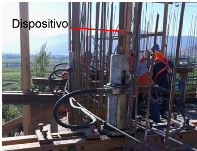
Imagen 5.22: Dispositivo de apriete colocado en Barra de Traspaso
