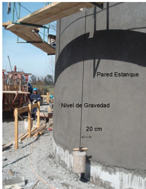
Imagen 5.21: Nivel de gravedad colocado en el moldaje deslizante
