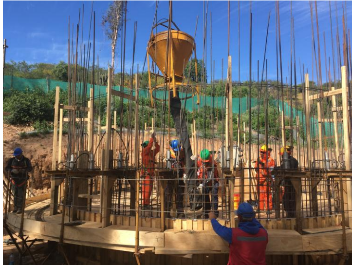
Imagen 5.24: Colocación y vibrado del hormigón en plataformas de trabajo superior
