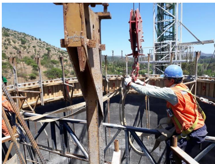
Imagen 5.32: Desmontaje plataforma de trabajo interior de sistema de moldaje deslizante
