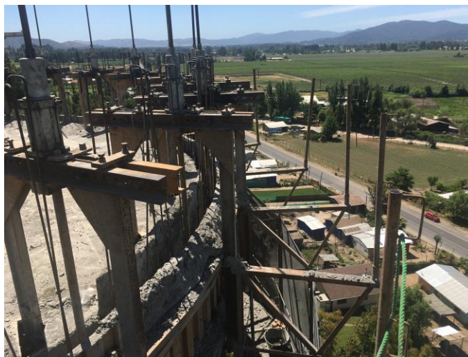
Imagen 5.31: Desmontaje plataforma de trabajo exterior de sistema de moldaje deslizante
