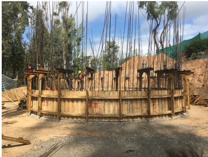
Imagen 5.9: Instalación de Gato Hidráulico y Encamisado
