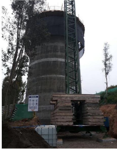
Imagen 5.3: Montaje de grúa para asistir a los trabajos del deslizado
