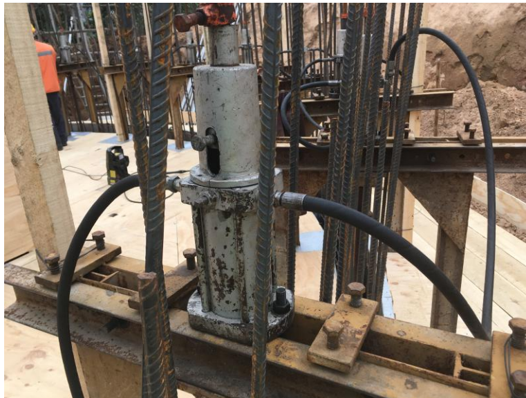
Imagen 4.2: Gato hidráulico sujeto a caballete
