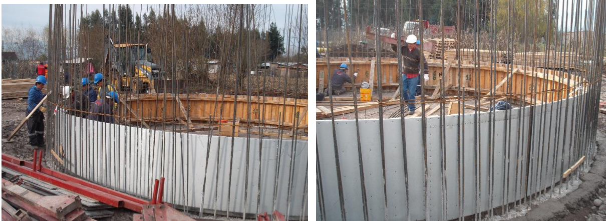
Imagen 5.4: Instalación de Molde Tipo A
