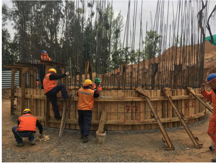
Imagen 5.7: Instalación de Caballete en cara exterior junto a Viga Travesaña
