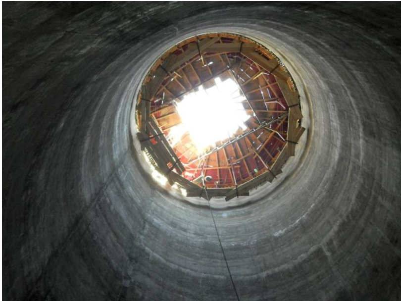
Imagen 5.13: Abertura interior del Sistema de Moldaje Deslizante
