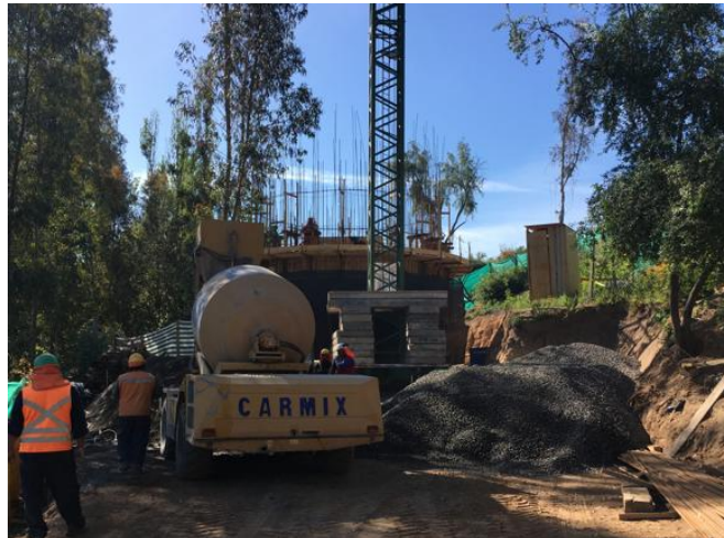
Imagen 5.20: Preparación de hormigón con Camión Hormigonero
