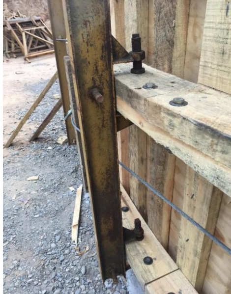
Imagen 5.8: Detalle de unión entre Caballete y Molde
