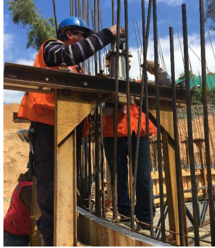
Imagen 5.10: Detalle de instalación de Gato Hidráulico y Encamisado
