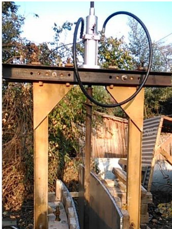
Imagen 4.1: Sistema de moldaje deslizante
