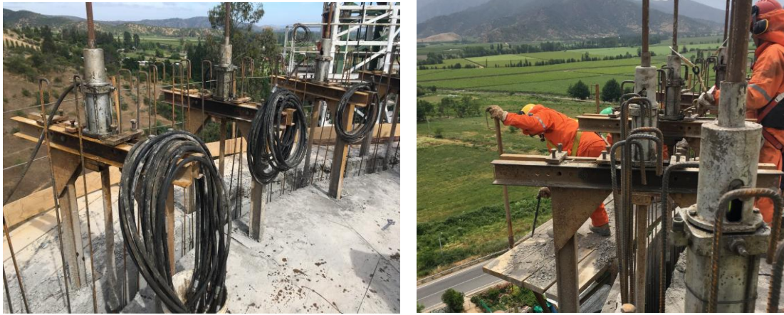
Imagen 5.29: Desmontaje sistema de elevación del moldaje deslizante
