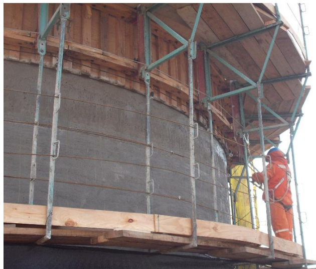
Imagen 5.25: Trabajos en plataformas de trabajo inferior externa
