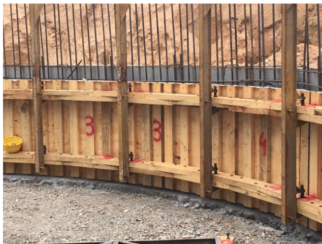
Imagen 5.5: Caracterización del Molde Tipo A
