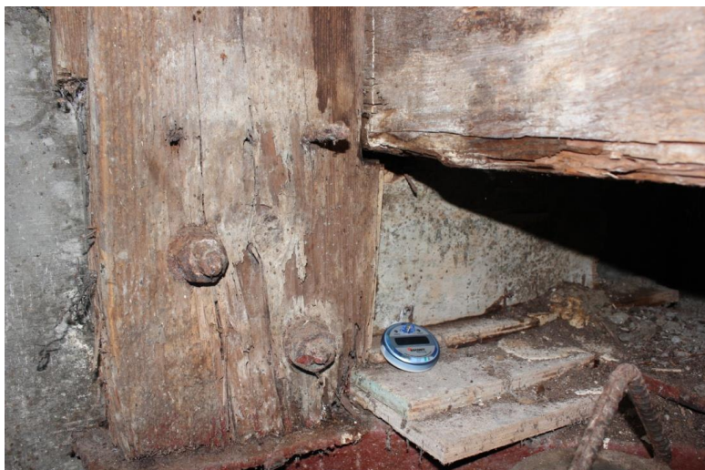
Figura 6. 2 Unión pilar P11 con fundación de la Torre Fuente: Elaboración propia
