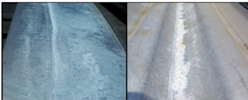
Figura 1. Mancha de óxido blanco que se ha formado entre defensas y planchas lisas almacenadas estrechamente.
