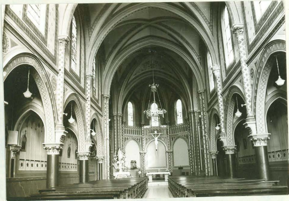
Desde la nave central hacia el ábside. ✓
