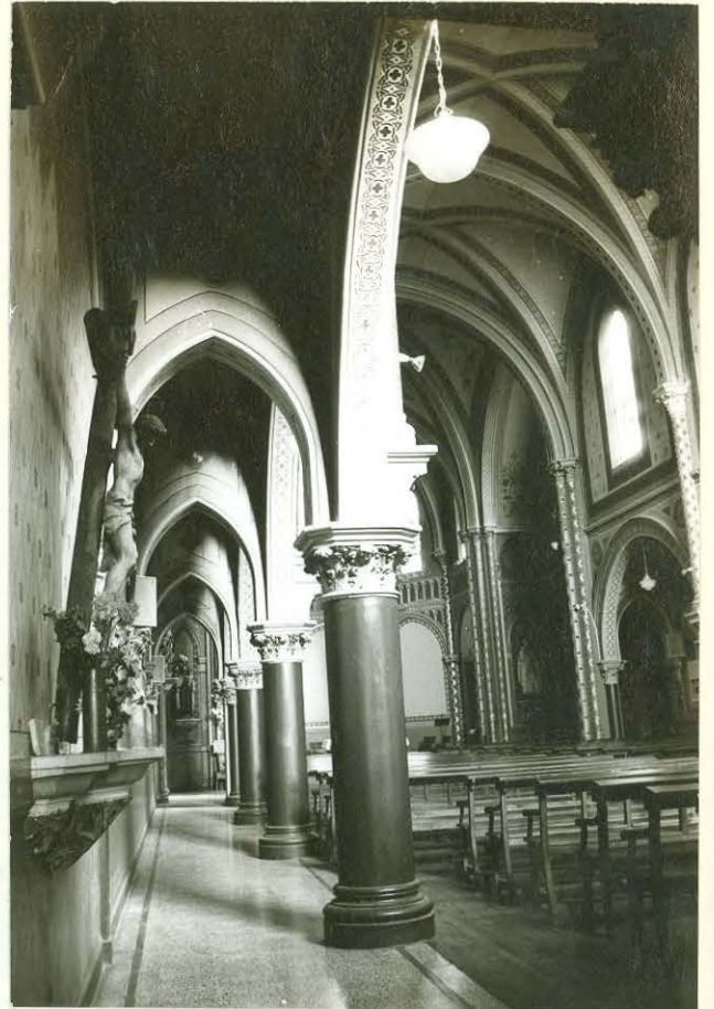
Desde la nave lateral hacia transepto.
