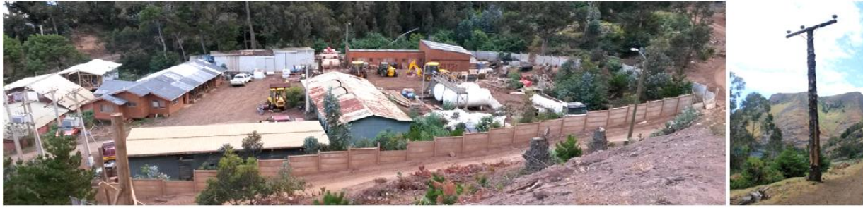
Imagen 13: Planta eléctrica y sistema de distribución
