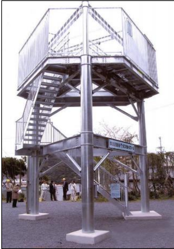
Figura 6-16 Torre Tasukaru, Japón. FEMA (2009)
