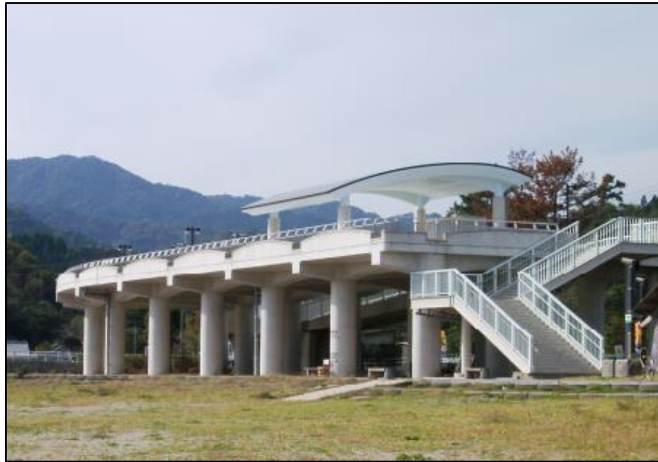
Figura 6-18 Refugio Elevado en Shirahama Beach Resort. FEMA (2009)
