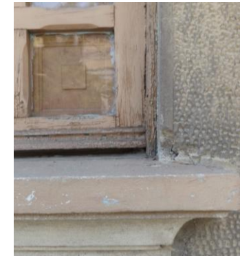
Fragmento de ventana y alfeizar. Se mantienen en buen estado en general, solo detalles de pintura.
