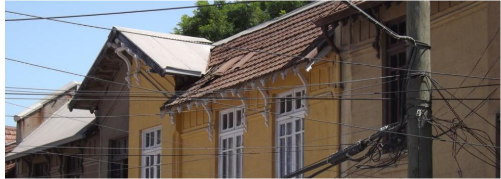
Detalle Techumbre (tejas), cornisas, con piezas de madera de apoyo.
