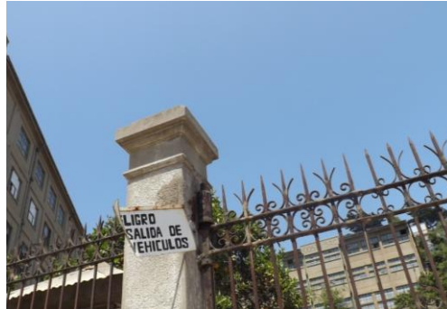
Fragmento de pilar de hormigón; Parte de enrejado.
