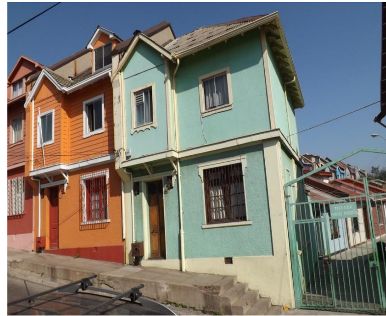
Detalle de enrejado terraza Borgoño y viviendas. Fuente propia, P. M. B.
