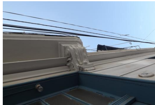
El conjunto destaca por poseer variada ornamentación que se da en los apoyos de balcones, interior, arriba puerta, etc.
