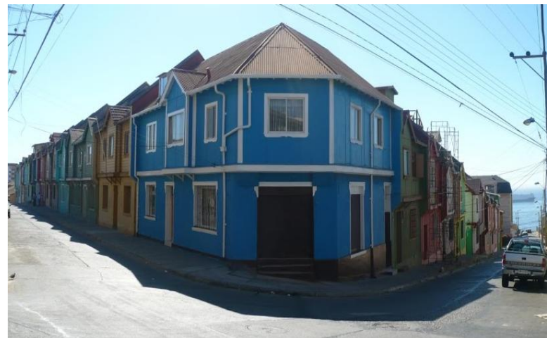
Viviendas Barros Borgoño, Vista general. Fuente Carlos Lara Aspee.
