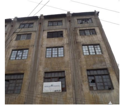
Detalle de ventanas, muros y parte de techumbre
