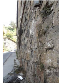
La fábrica posee grandes zócalos que pueden llegar a superar los 2 mts de altura.
