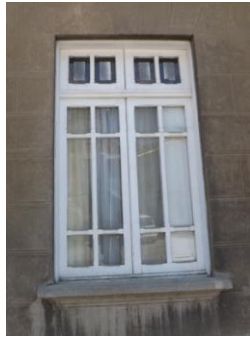
Detalle de ventana. Marco de madera, estructura original aun se mantiene
