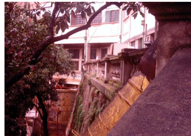
Muro de piedra y detalle de barandas.
