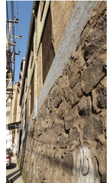
Detalle de zócalo. Fuente propia P.M.B.
