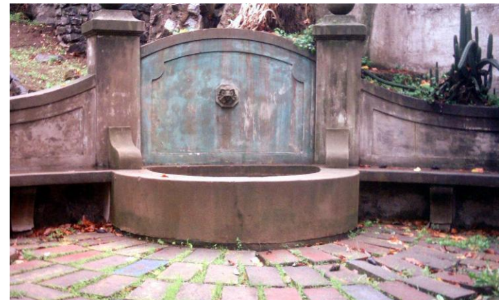
Detalle de pileta, primera etapa de construcción. Fuente: Rehabilitación fábrica Costa, vivienda + cultura, proyecto título 2004, Marcía Elgueta Acevedo, Universidad de Chile
