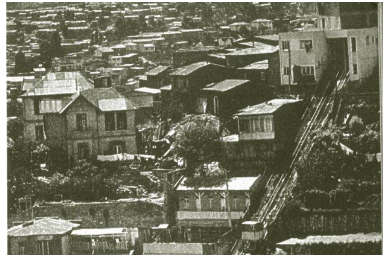
Viviendas que habitan la quebrada Jaime. http://ascensoresvalparaiso.org/content/fotos/ascensor-la-cruz-0
