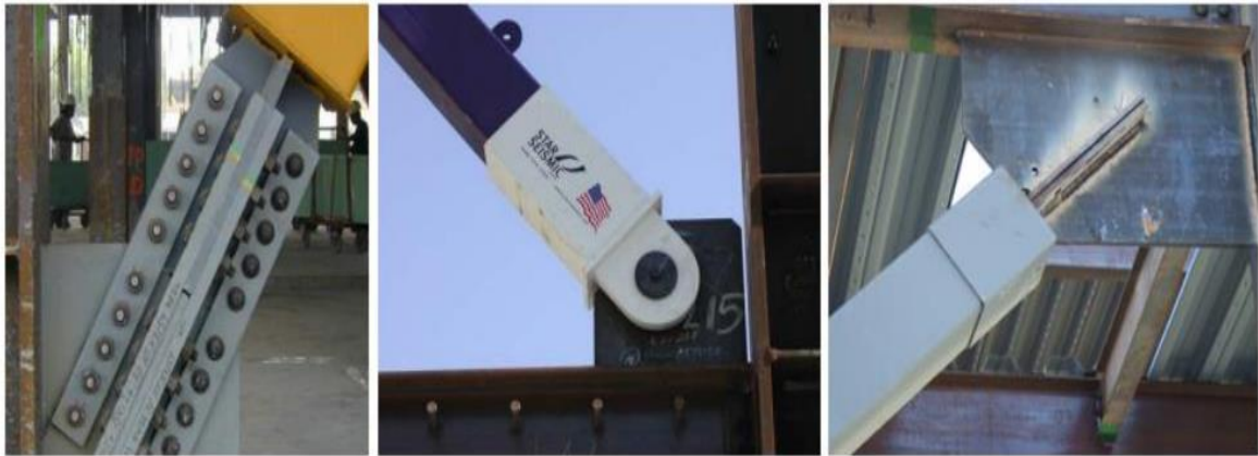
Figura 2. 15: Conexión apernada, rotulada y soldada en diagonales BRB [52].
