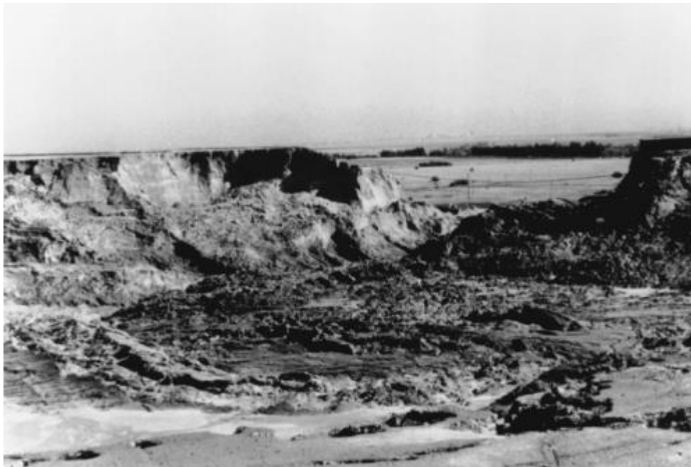
Figura 2.8 - Falla de tranque de relave debido a licuación estática, Merriespruit. [41]
