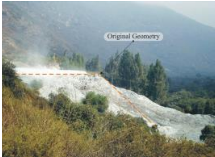
Figura 2.4 - Deslizamiento de talud en tranque de relave en un evento sísmico [39]
