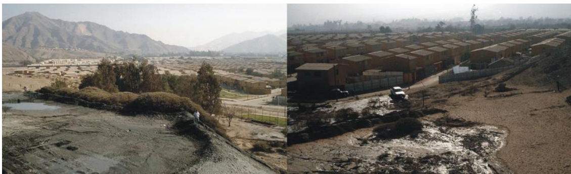
Figura 2.6 - a) Tranque de relaves con aguas claras próxima al coronamiento b) falla de flujo en sentido descendente [39]
