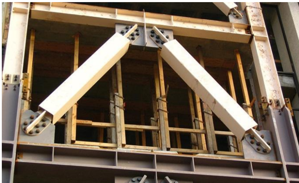
Figura 2.6.1: Arriostramiento BRB en estructura de acero [39]
