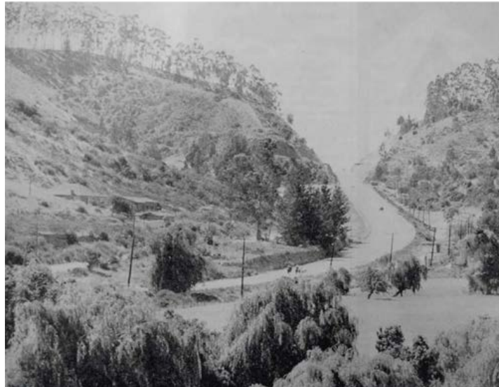
Camino a Santiago año 1963, imagen del corte La Quinta, obra ejecutada por INELA Fuente: Hitos de la Ruta 68, litoralpress.cl
