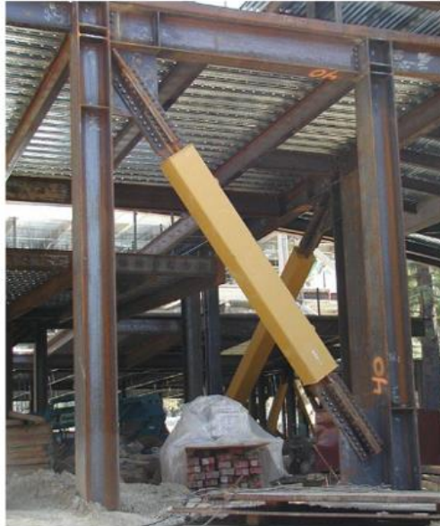
Figura 1.1: Vista de una riostra BRB [9].
