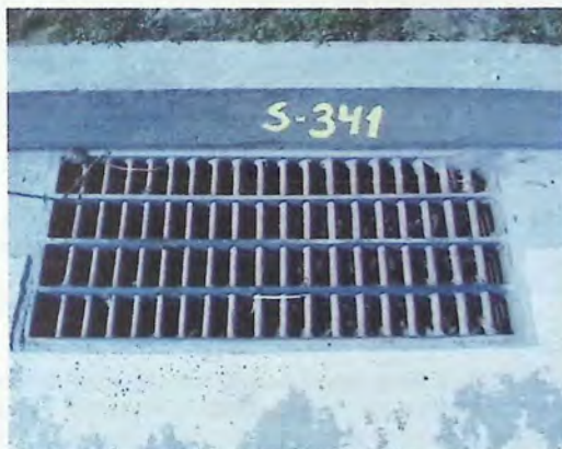
Figura 5.12 – Sumidero SERVIU S1 sector Av. Costanera
