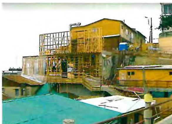
Imagen 29 Gallardo, P. (2017) Restauración estación superior Ascensor Espíritu Santo. Valparaíso, Chile.
