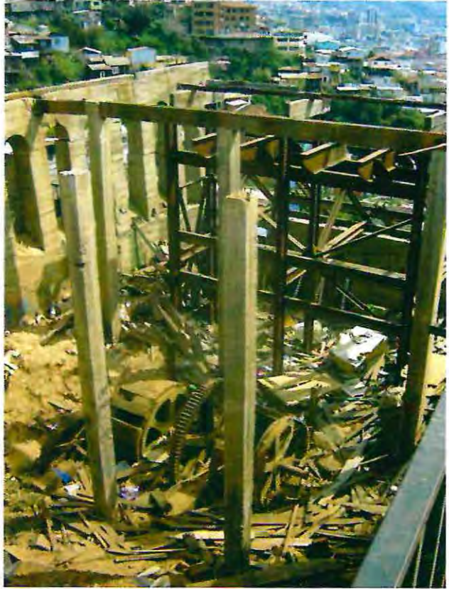
Imagen 49 Demolición Ascensor Las Cañas, año 2011. Rescatada de www.cerroconcepcion.org
