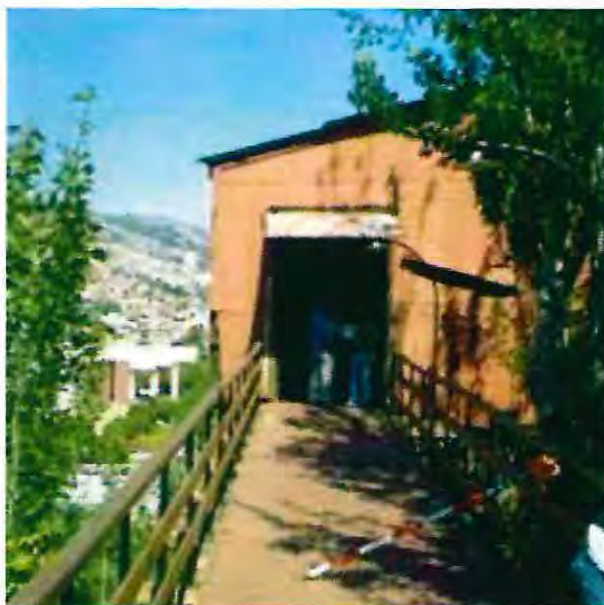
Imagen 84 Pasarela estación superior Ascensor Larraín, año 2012. Rescatada de www.ascensoresdevalparaiso.blogspot.com
