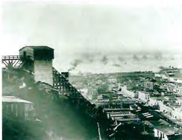
Imagen 45 Ascensor Monjas (1916). Rescatada de https://www.enterrero.com/moments/valparaiso-1916
