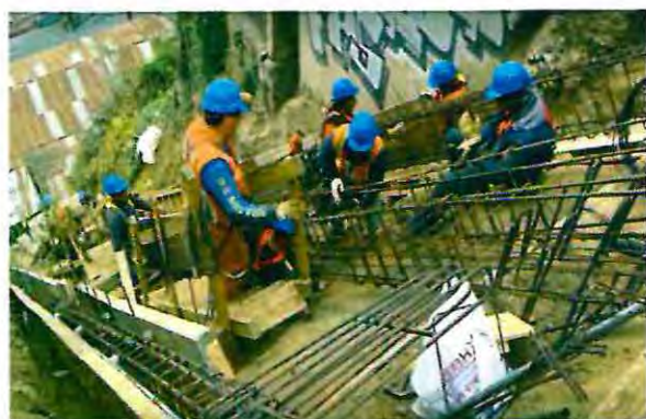
Imagen 31 Gallardo, P. (2017) Restauración Ascensor Espíritu Santo. Valparaíso, Chile.
