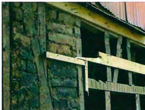
Imagen 129 Jimenez, M. (2015) Relleno de adobillo en tabiquerías casa Dimalow 167
