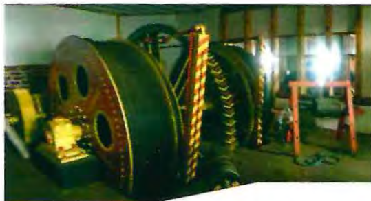
Imagen 133 Gallardo, P. (2016) Sala de máquinas Ascensor Artillería.
