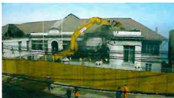
Imagen 28 Gallardo, P. (2014) Demolición Ex - Hospital Ferroviario. Valparaíso, Chile.
