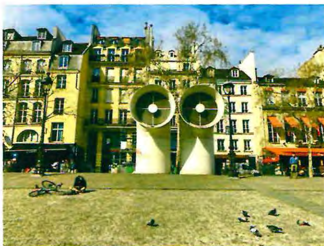
Imagen 18 Gallardo, P. (2019). Centre Georges Pompidou, ductos de ventilación en plaza y Rue du Renard. París, Francia.
