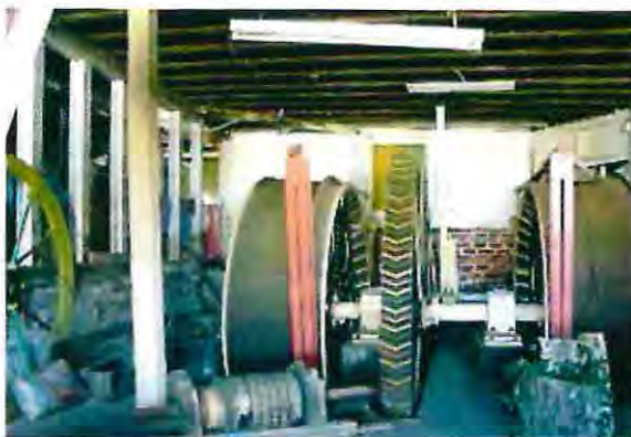
Imagen 148 Triviño, L. (2013). Sala de máquinas de Ascensor Artillería obsoleto.
