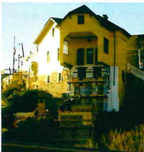
Imagen 115 Ascensor Barón en proceso de restauración. Año 2012. Rescatada de www.emol.cl
