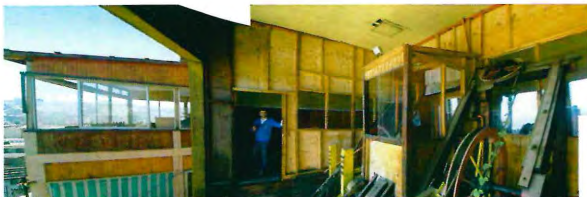
Imagen 136 Gallardo, P. (2016) Estación superior Ascensor Espíritu Santo
