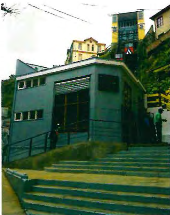
Imagen 144 Cyparq (2012) Restauración, mantención y ampliación de Ascensor Reina Victoria.
