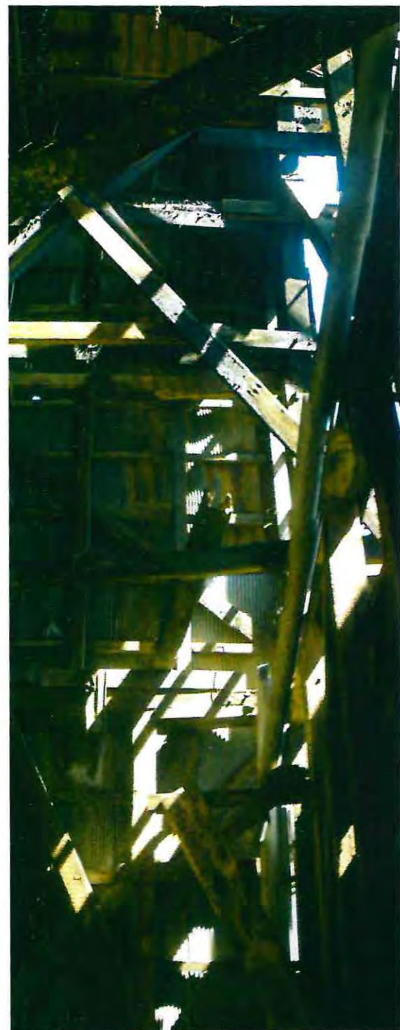
Imagen 132 Gallardo, P. (2016) Entramado vertical en estación superior Ascensor Monjas
