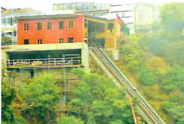
Imagen 78 Estación superior Ascensor Concepción, en proceso de restauración, año 2018. Rescatada de www.latercera.com
