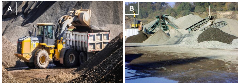
Figura 4.2- A) Acopio y carga de los áridos del Aconcagua B) Proceso de chancado y Tamizado.
