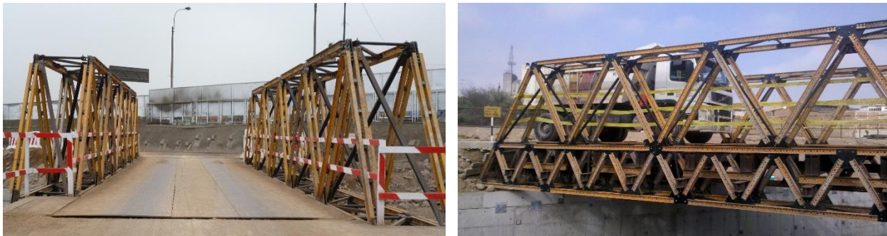
Figura 3.4: Puente paso camión [Fotos gentileza de ULMA Construction].
