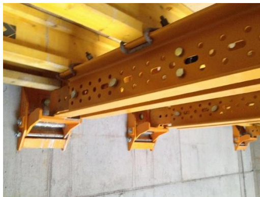
Figura 3.9: Riostra MK (Doble UPN-120). [Foto gentileza de ULMA Construction].
