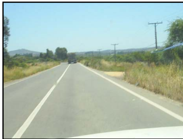
Figura 11: Deterioro de carreteras por tránsito vehicular
