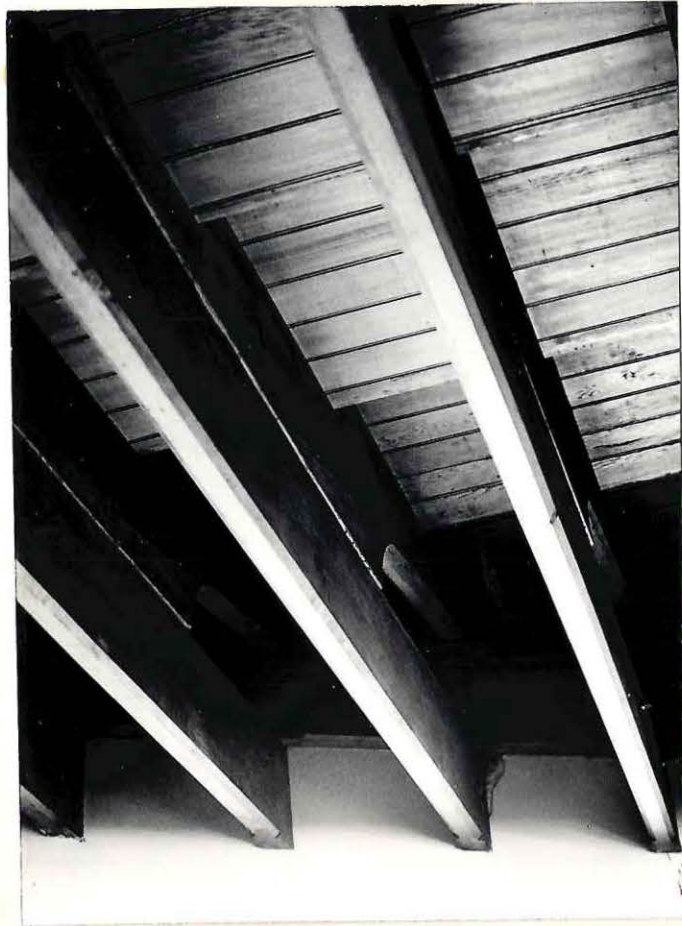
14.- Detalle de la viga maestra, y de la viga escalonada de la nave lateral alta.
