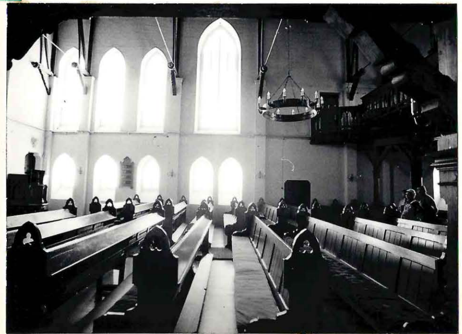
13.- Nave principal, vista desde nave lateral.
