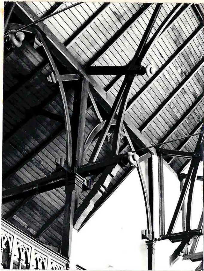
16.- Arcos de la nave lateral.
