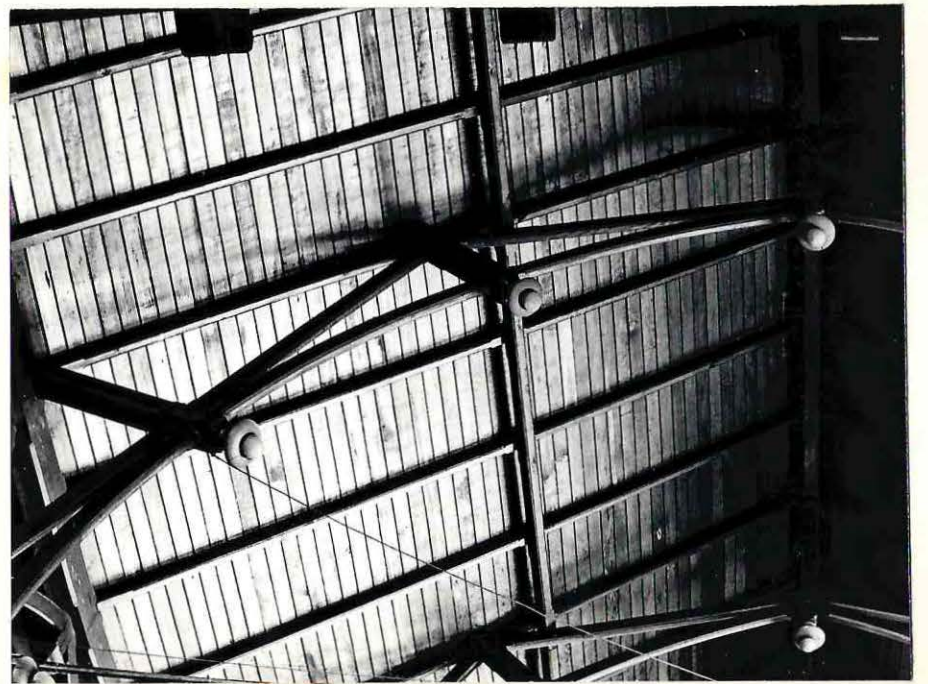
19.- Detalle del cielo y techumbre de la nave principal.
