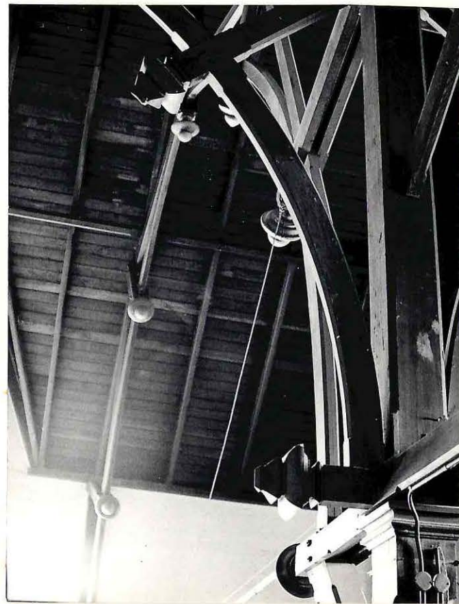
17.- Unión del arco y pilar de la nave lateral.
