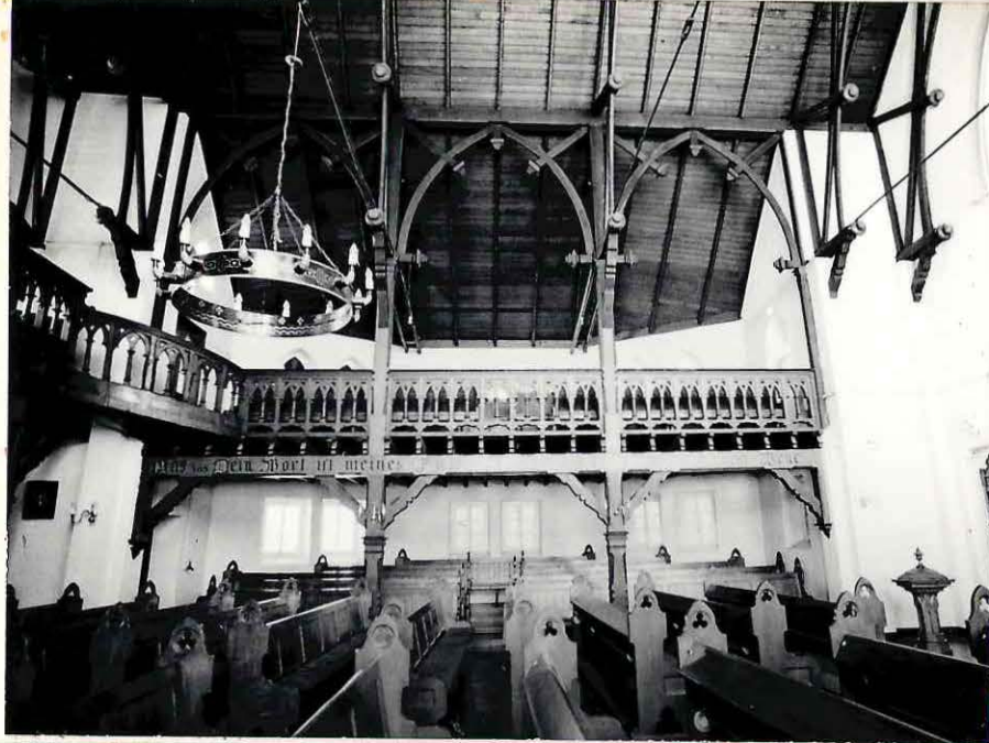
12.- Nave lateral, vista desde la nave principal.
