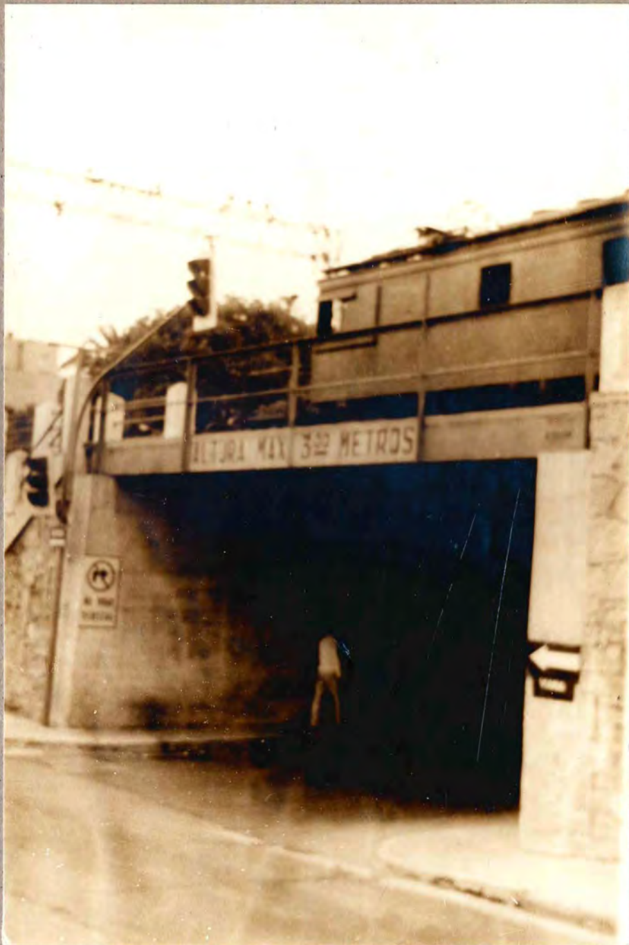
Cruce BAJO nivel calle Cerro
