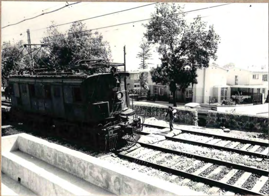
Cruce A nivel calle Ocoa
