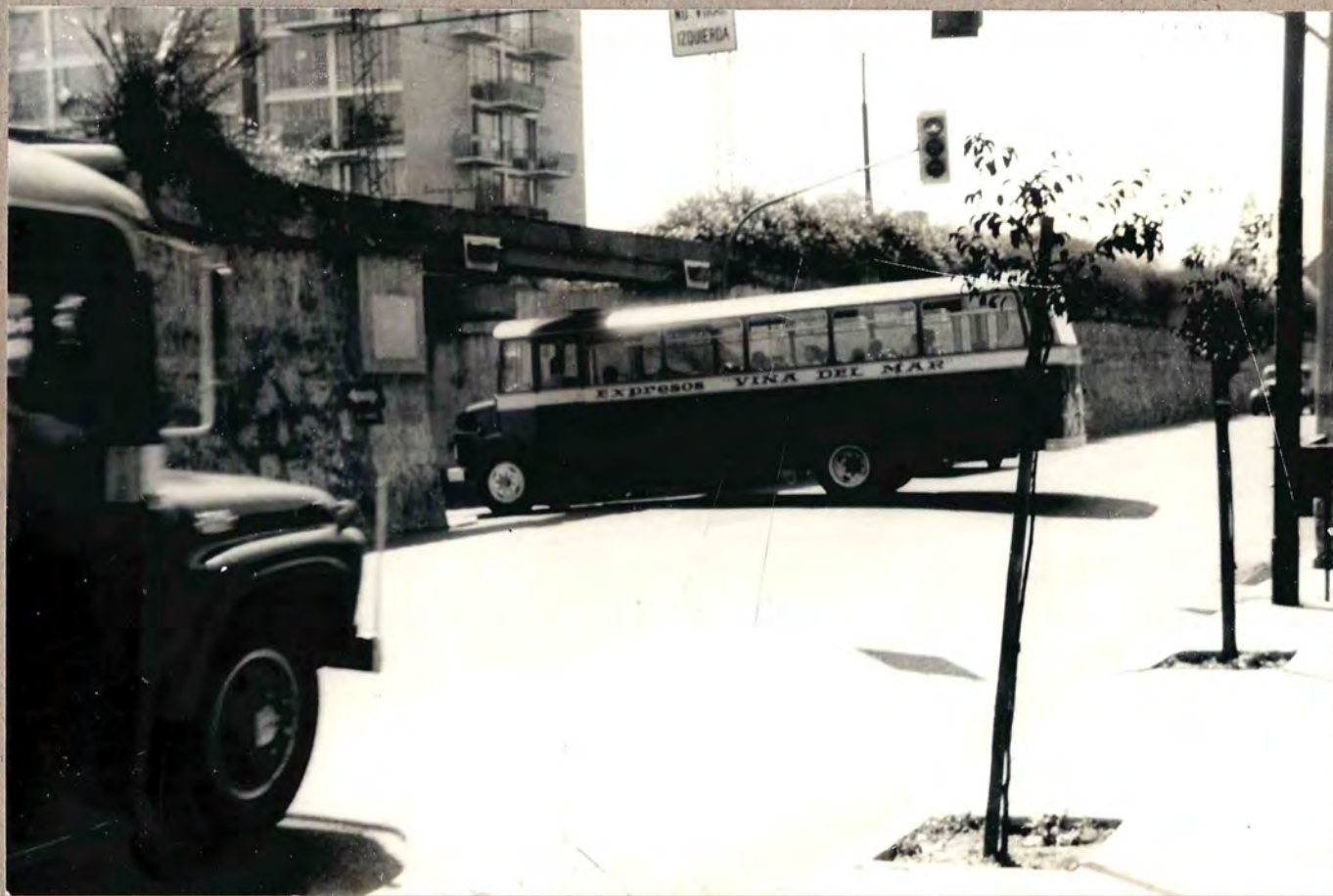
Cruce calle Traslavina
