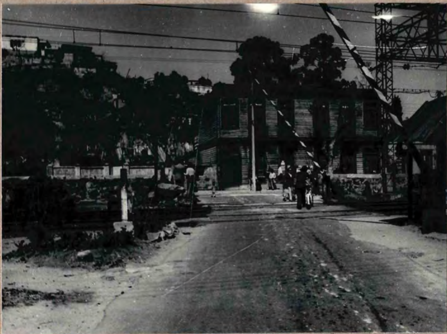
Cruce A nivel calle Montenegro
