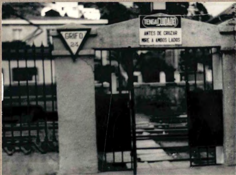
Cruce A nivel C.R.A.U.
