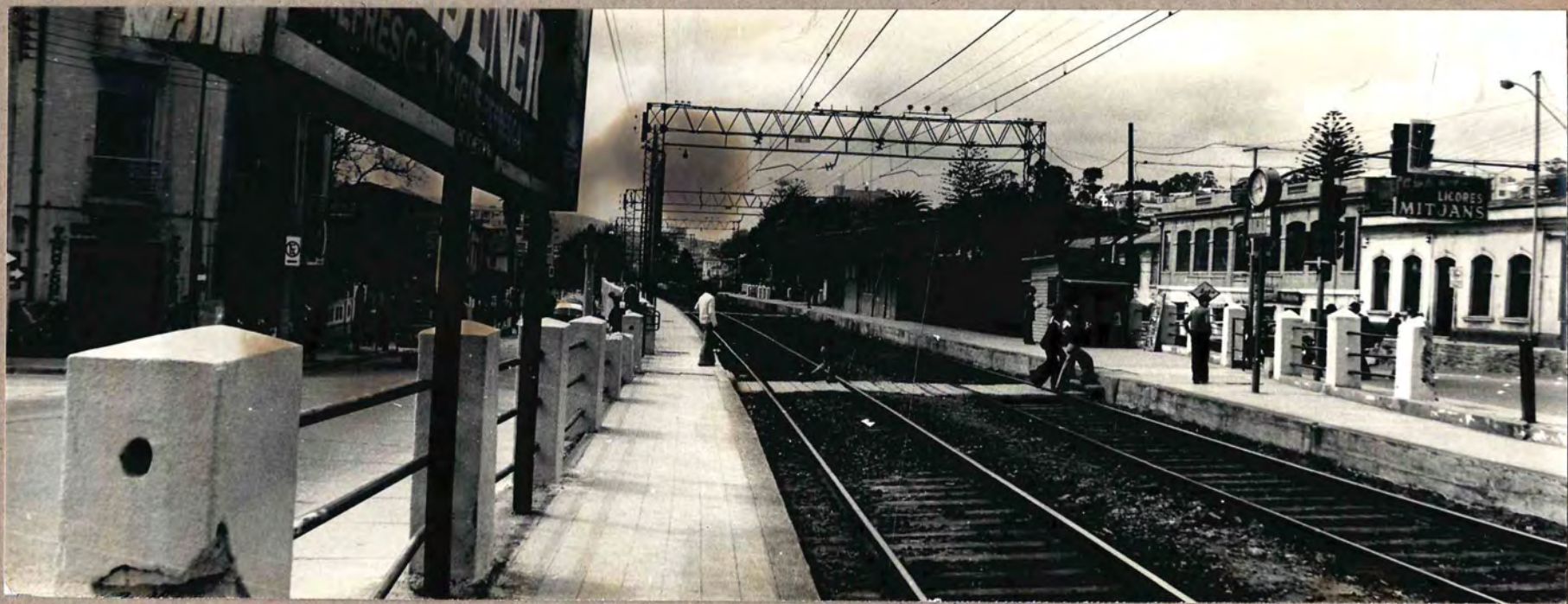
Cruce peatonal de Agua Santa
