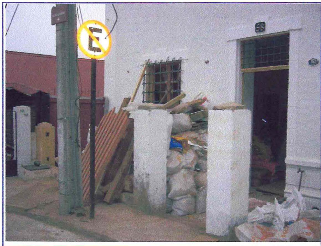
Foto N° 28: "Construcción de Hotel en Paseo Atkinson, Cerro Concepción"
