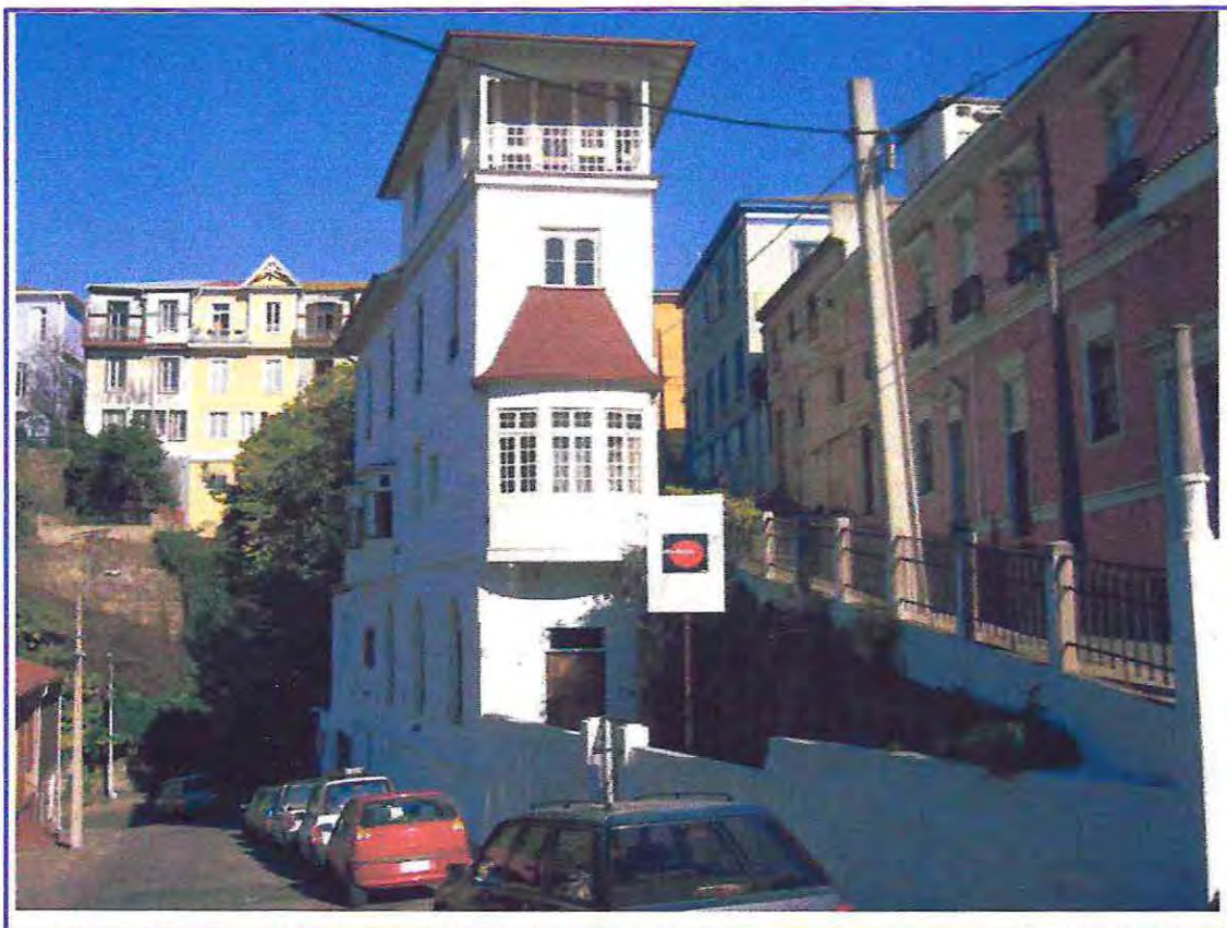
Foto N° 37: "Construcción típica, Cerro Alegre"
