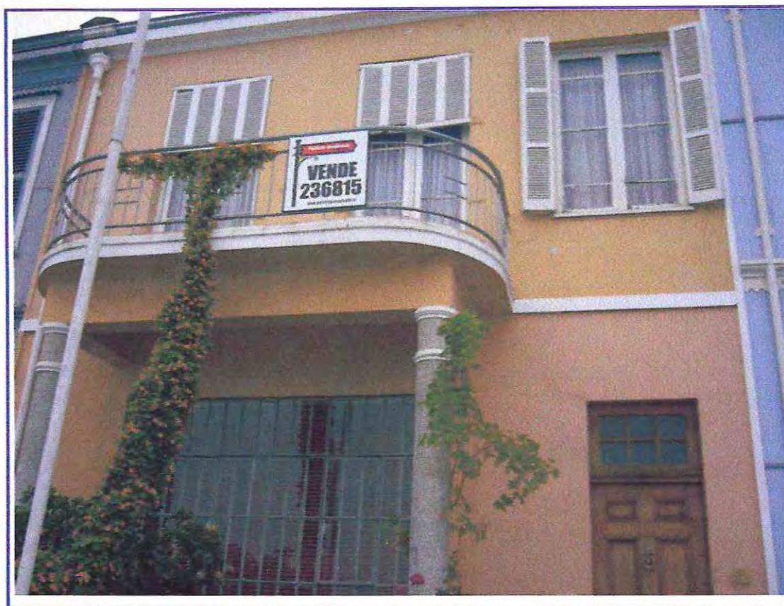
Foto N° 24: "Oferta habitacional en Paseo Atkinson, Cerro Concepción"
