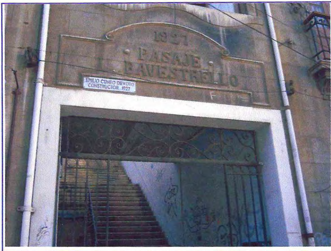
Foto Nº 7: "Edificio Bavestrello, Cerro Alegre"
