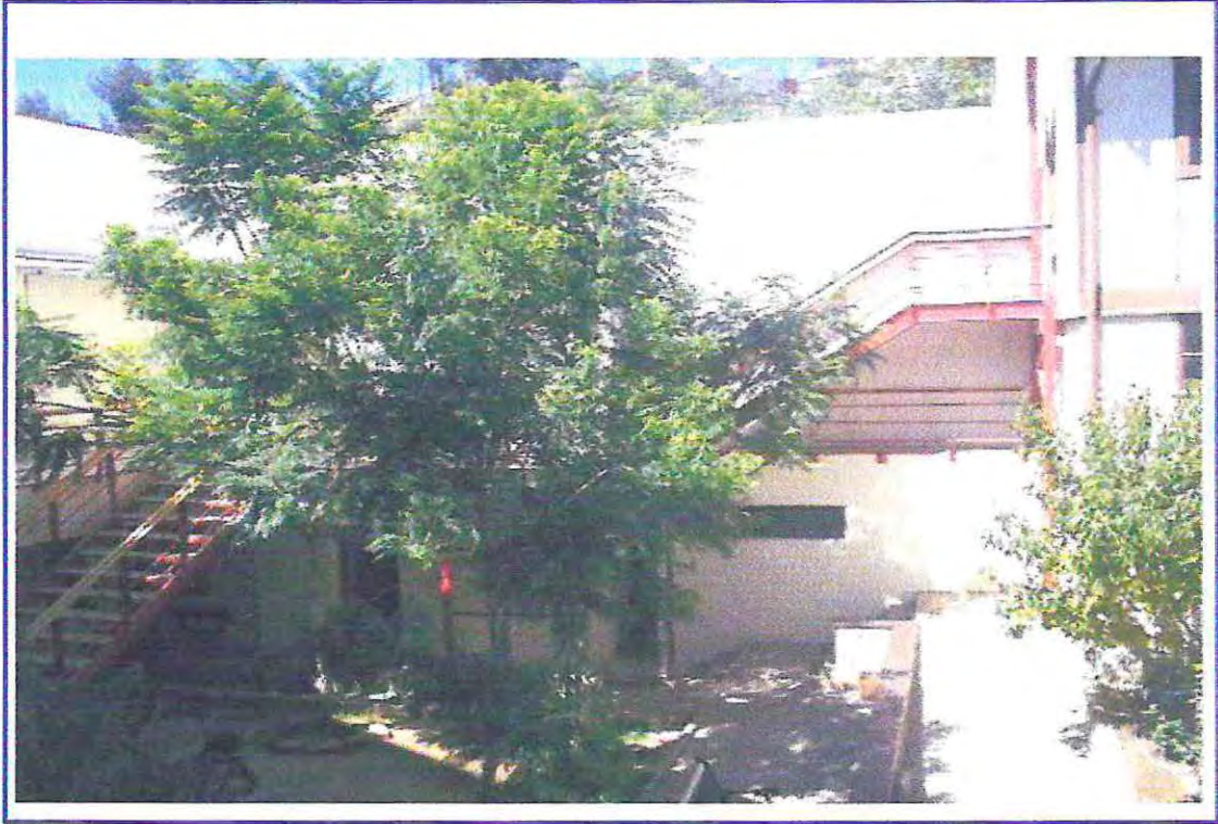
Foto N° 4: "Patio Escuela de Trabajo Social, Universidad de Valparaíso"
