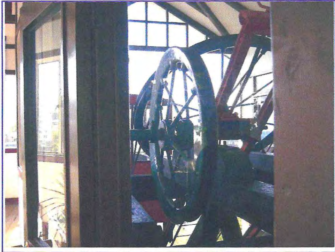
Foto N° 5: "Interior del Ascensor El Peral, Cerro Alegre"
