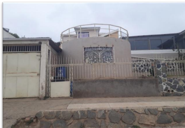
Imagen 3: Estanque de agua que abastecía a los habitantes del cerro Esperanza y se mantiene hasta el día de hoy. Actualmente es una bodega perteneciente a una casa en calle Los Boldos. Elaboración propia.
