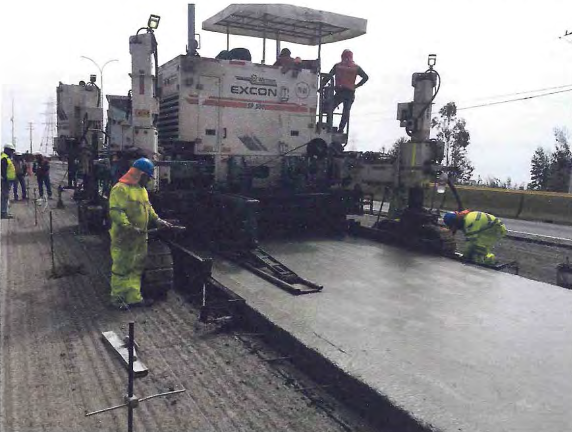
Figura 6.1 Construcción de Losas Optimizadas Obra Camino la Pólvora, 2016.
