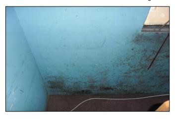
El fenómeno de condensación que se da mayormente en muros perimetrales de la vivienda. En esta imagen el muro mostrado en el lado derecho es el perimetral y el del lado izquierdo es un muro divisorio del interior de la vivienda. Esto nos demuestra son los muros perimetrales son más propensos a ser afectados por el crecimiento de hongos, ya que son los que están expuestos a las temperaturas exteriores y los que a su vez carecen de optima aislación térmica.
