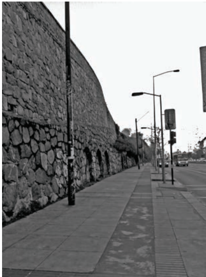
MUROS DE PIEDRA
