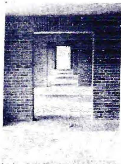
Pilarización de la planta baja.
