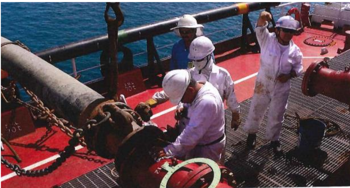
Figura 3.14. Conexión manifold con mangueras flexibles
