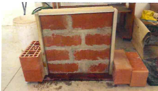
Figura 4.15: Moldaje Muro Albañilería
