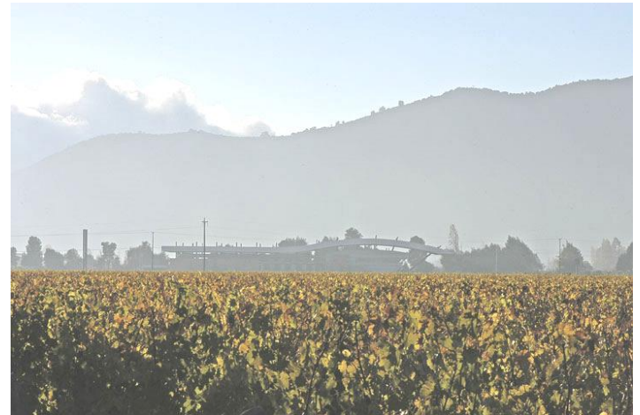
Fig. 99 La imagen muestra el perfil de la cubierta de la bodega perteneciente a la viña Estampa.
