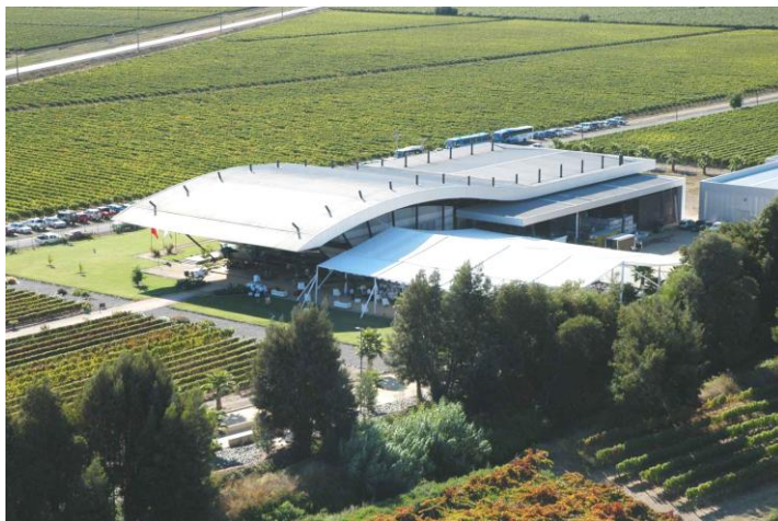
Fig.100 Vista de la bodega de viña Estampa y su relación con los caminos principal (fondo de la imagen) y secundario, costado de la bodega.
