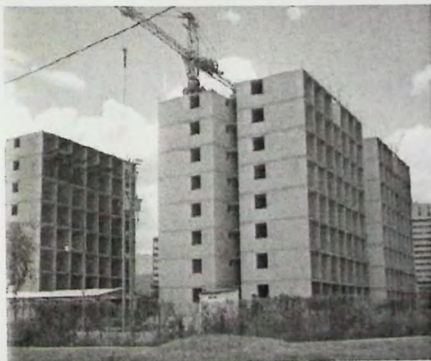
Figura 2.3 - Edificios con muros delgados en Venezuela [4].
