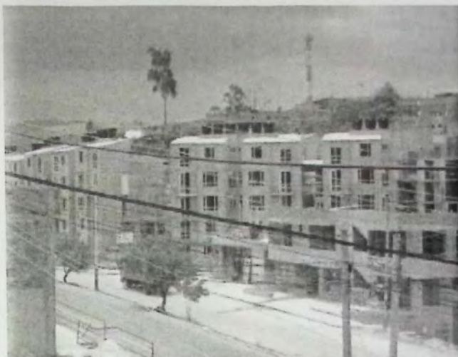
Figura 2.2 - Edificios con muros delgados en Colombia [3].
