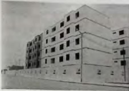
(a) Edificio con muros continuos en altura
