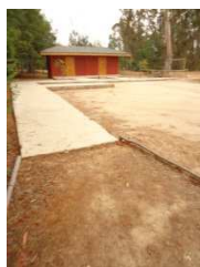
Imagen N° 22, Acceso baños sendero Los Coipos
