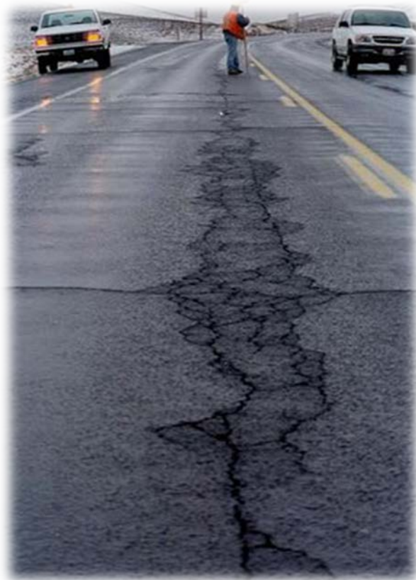
Figura 2.1: Fallas por humedad
